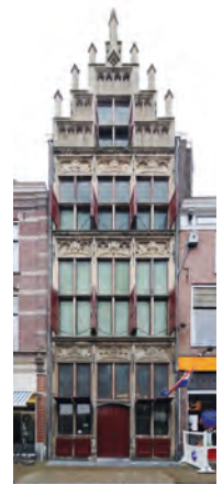
77 Voorgevel van het Gotische Huis, Oudestraat 158 te Kampen, gebouwd omstreeks 1499. De zones boven de vensters bevatten per venster één gotische letter. Na een eerdere vernieuwing werden die van boven de begane grond in 1908 (onbegrepen) gerestaureerd: hier horen de letters IHS (Jezus) te staan. Boven de eerste verdieping staat MAR (Maria) en de tweede verdieping JOH (Johannes)
