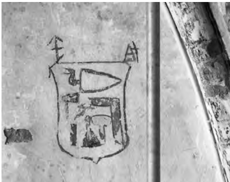
33 Geschilderd wapenschildje met metselaars- en steenhouwersgereedschappen, aangebracht op de oostgevel van het noordelijk transept en ‘opgehangen’ aan twee steenhouwersmerken in de Martinikerk te Groningen Foto: RCE Amersfoort
