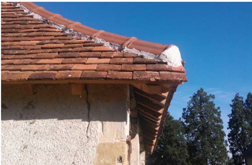
Afb. 6.26 Voorbeeld van het gebruik van mortel in een dak in Nohant en Gracay, Frankrijk.
