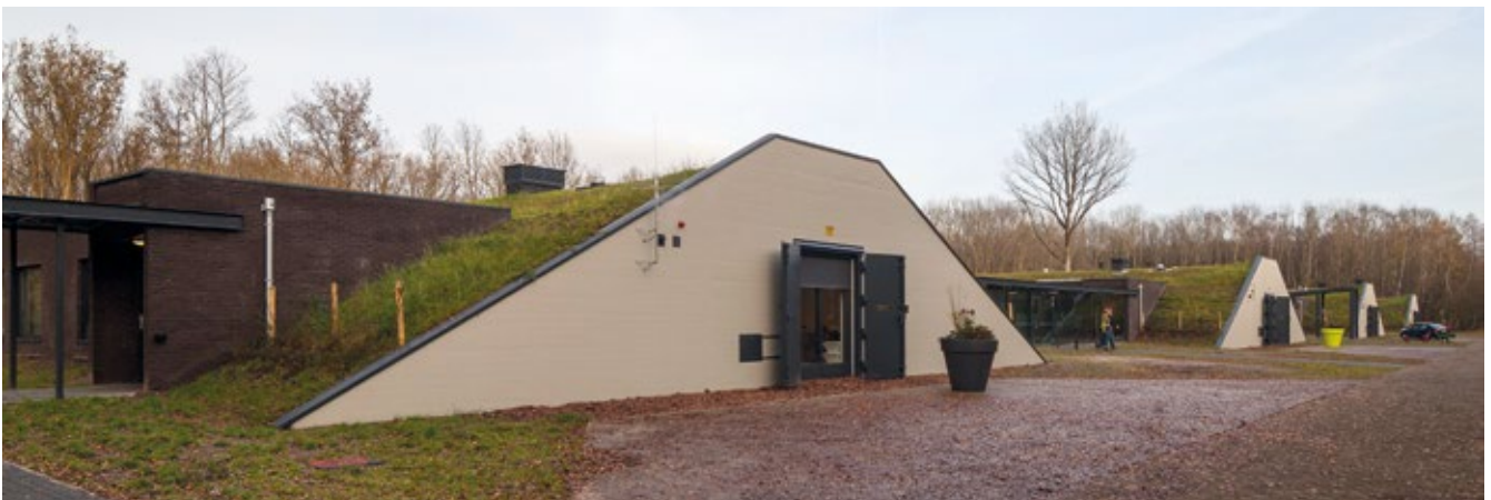
Vier bunkers bij Ommen die sinds eind jaren vijftig dienden om munitie in op te slaan, vormen nu het ideale, prikkelarme woonverblijf voor autistische patiënten
