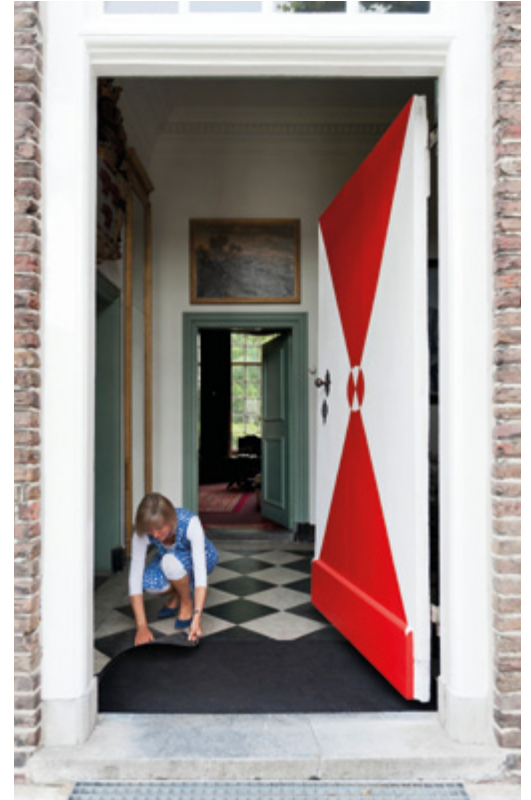
Beheerder Fransje Thijssen inspecteert of het vochtig is onder de mat
