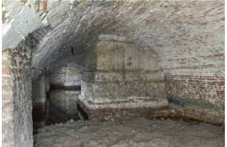
117 De gemetselde tongewelven onder de Snoge met de gemetselde voet van de kolom die het gewelf doorsnijdt.
