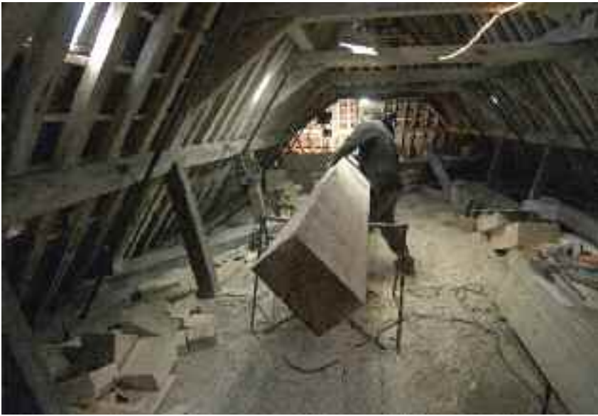
119 Balkherstel in de kap van de Snoge.
