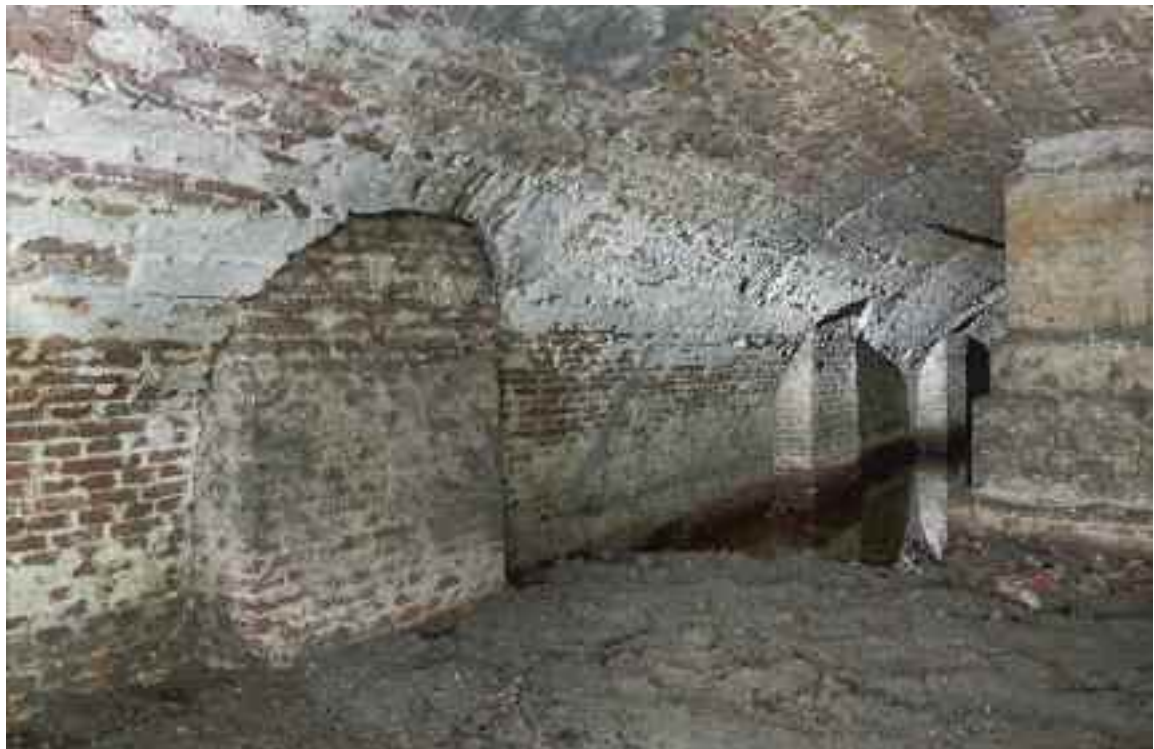
62 De gewelven onder de synagoge met de poeren onder de vrouwengalerij (links) en de poer onder één van de hoofdzuilen (rechts).
