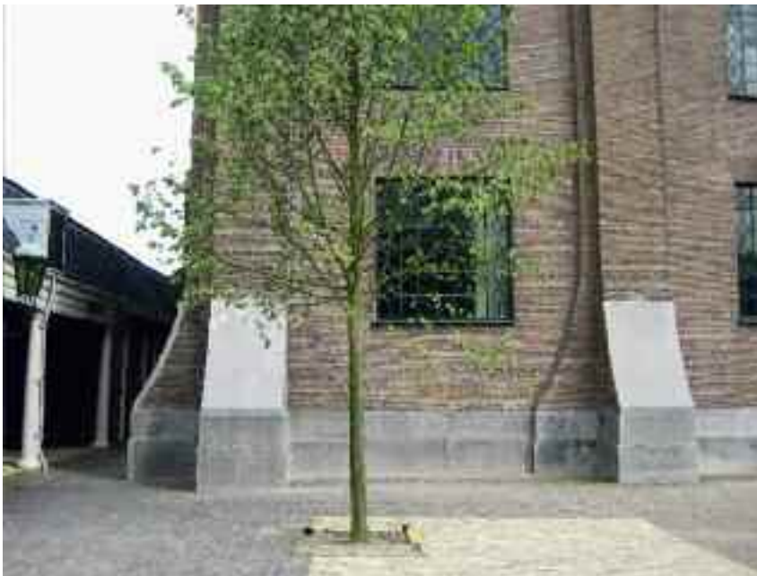
55 De hoek van de voorgevel met de als ornament gebruikte uitzwenkende steunberen.
