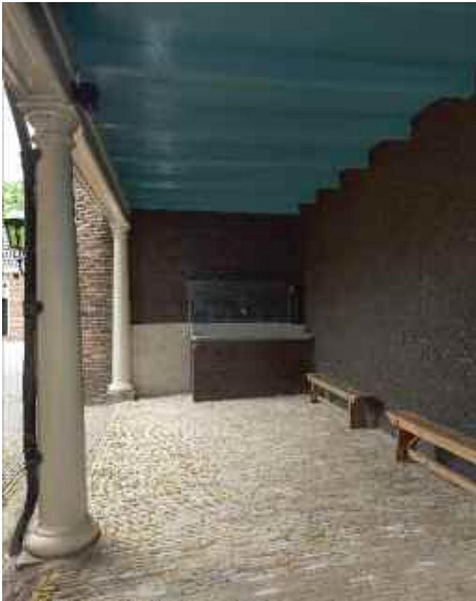
45 Restant van de Toscaanse zuilengalerijen met de waterbak voor het wassen van de handen.
