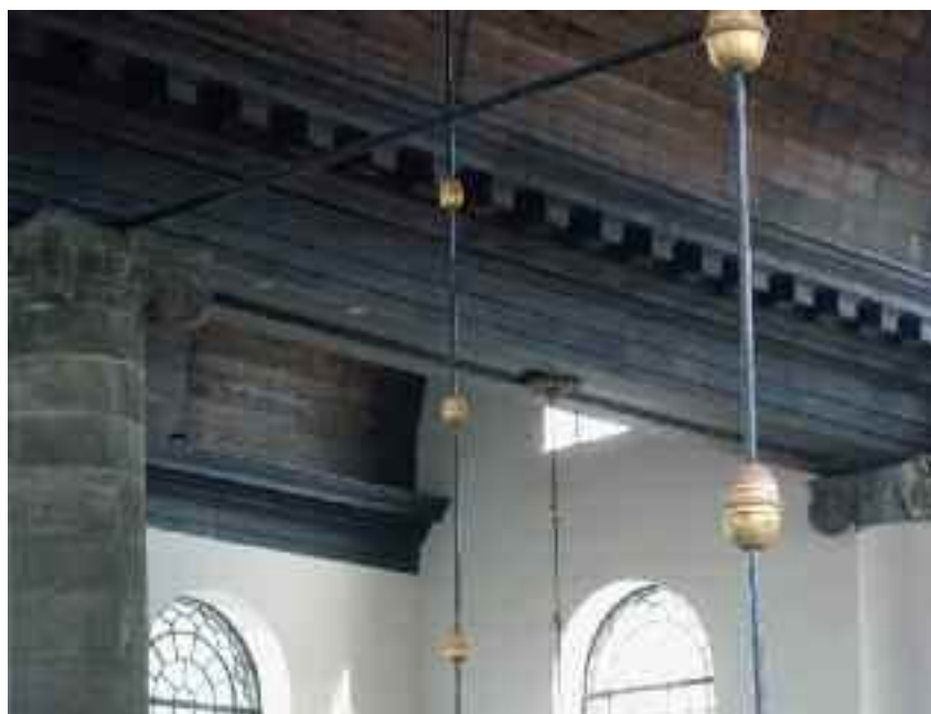
50 Het zware lijstwerk van de middenbeuk en het minder hoge lijstwerk van de zijbeuk.
