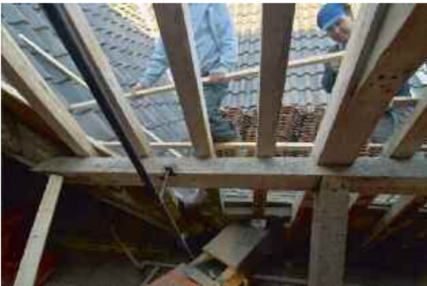
120 Het herleggen van de dakpannen op de Snoge. Op de gording is het jaartal 28 september 1788 zichtbaar.
