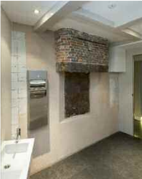
108 De vloer van het souterrain is uitgediept. De oorspronkelijke vloer lag aan de onderzijde van de zeventiende-eeuwse ijzeren haardplaat en de onderkant van de witjes op de wand.
