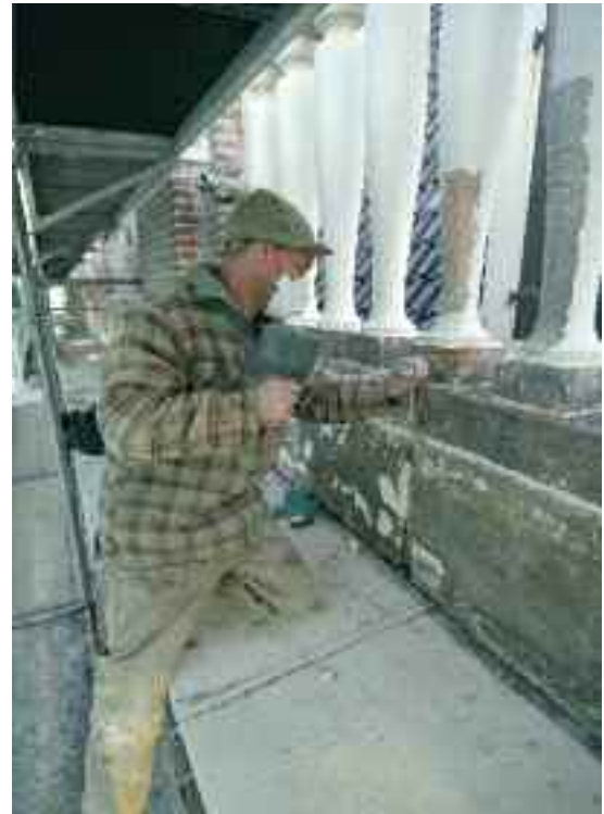
121 Het uithakken van voegen en oude reparaties aan de zandstenen onderdelen van de balustrade.
