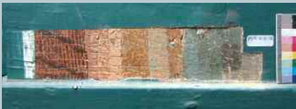
84 Stratigrafie op de buitenzijde van een van de risalieten van het hekwerk op de vrouwengalerij. Met een chirurgisch scalpelmes zijn de verflagen trapsgewijs één voor één vrijgelegd, zodat een beeld ontstaat van alle verschillende aanwezige verflagen. Links de meest recente verflaag, rechts de oudste grijze afwerking.
