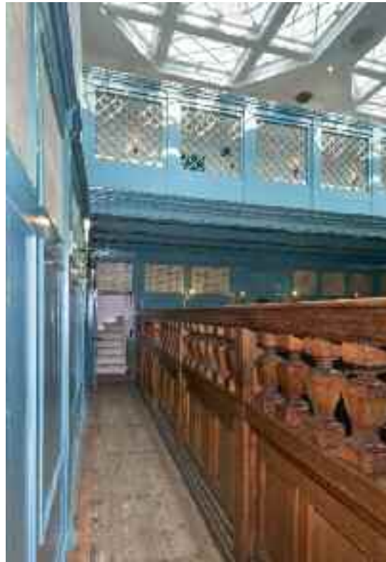
111 De nieuwe toegang tot de vrouwengalerij in de wintersynagoge. Door deze ingreep is de vrouwengalerij logistiek gescheiden van de kantoorruimten.
