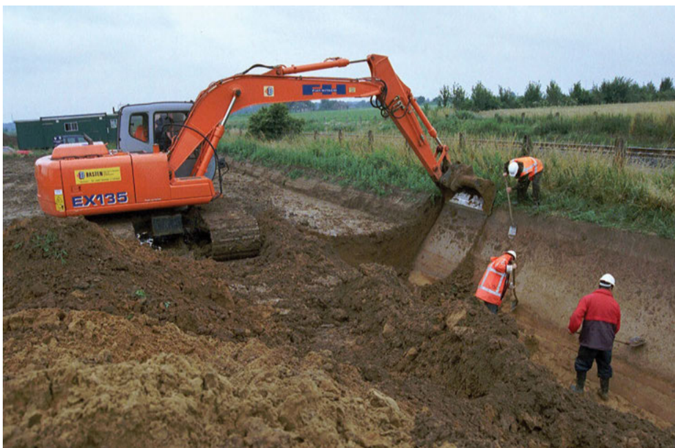
Afb. 5 De aanleg van het profiel.
