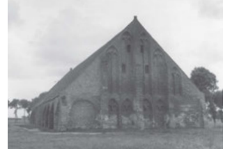
Afb. 30 De tiendschuur van de Abdij Ter Doest te Lissewege (België West-Vlaanderen) uit 1275, exterieur.
