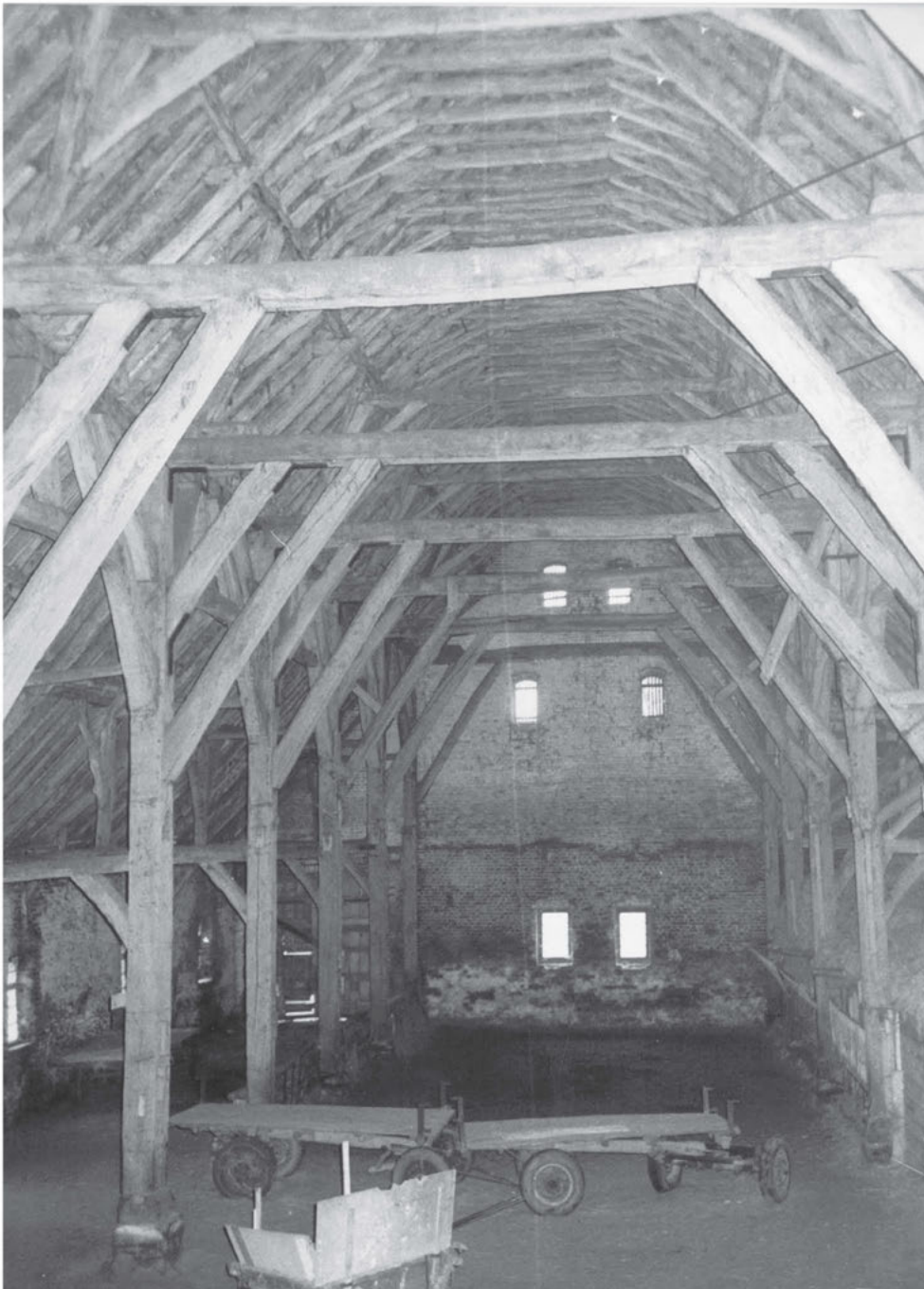
Afb. 31 Het interieur van deze tiendschuur. Hierop is de houtconstructie duidelijk zichtbaar. Het betreft op stiepen geplaatste staanders en een kapconstructie (foto's van de Stichting Historisch Boerderij Onderzoek (SHBO), met dank aan Judith Toebast (RCE)).
