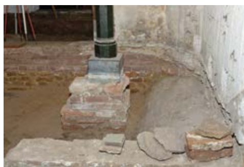
Afb. 4.9 Gemetselde grafkelder (spoor 14) aan de zuidoostzijde van het koor. Foto genomen naar het oosten.
