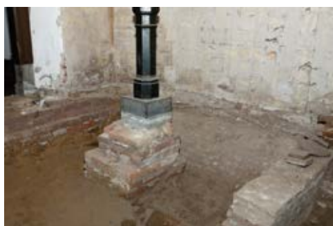
Afb. 4.8 De fundering van een van de gietijzeren palen van het balkon (spoor 13). Foto genomen naar het zuidoosten.
