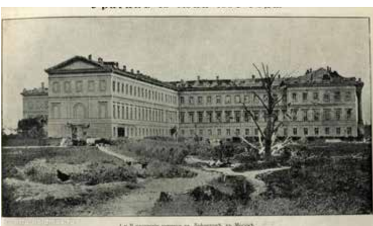
De stormschade aan het Annahof-paleis (sit. 1904)
