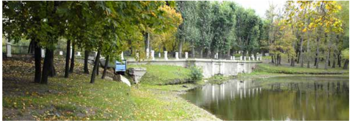
Zicht op de Venus-dam vanuit het oude 'waterpark'
