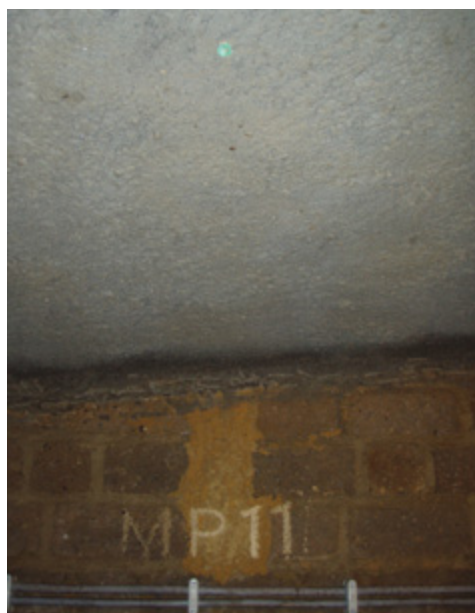
Afb. 2.3 De markering op de muur en de (groene) messing bout in het plafond.
