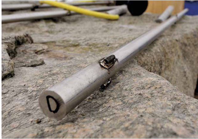
Op de gelijmde deksteen liggen staven die er ter wapening in zullen worden gebracht
