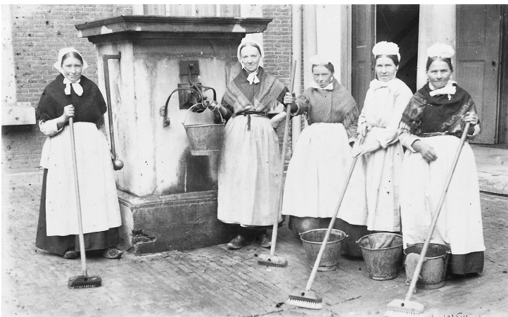
De pomp op de binnenplaats van het Kasteel van Breda in 1900
