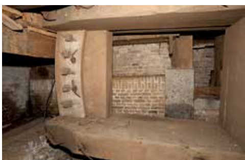
Afb. 24 Binnenkant van de Oostmolen met ijzeren kamnagels.
