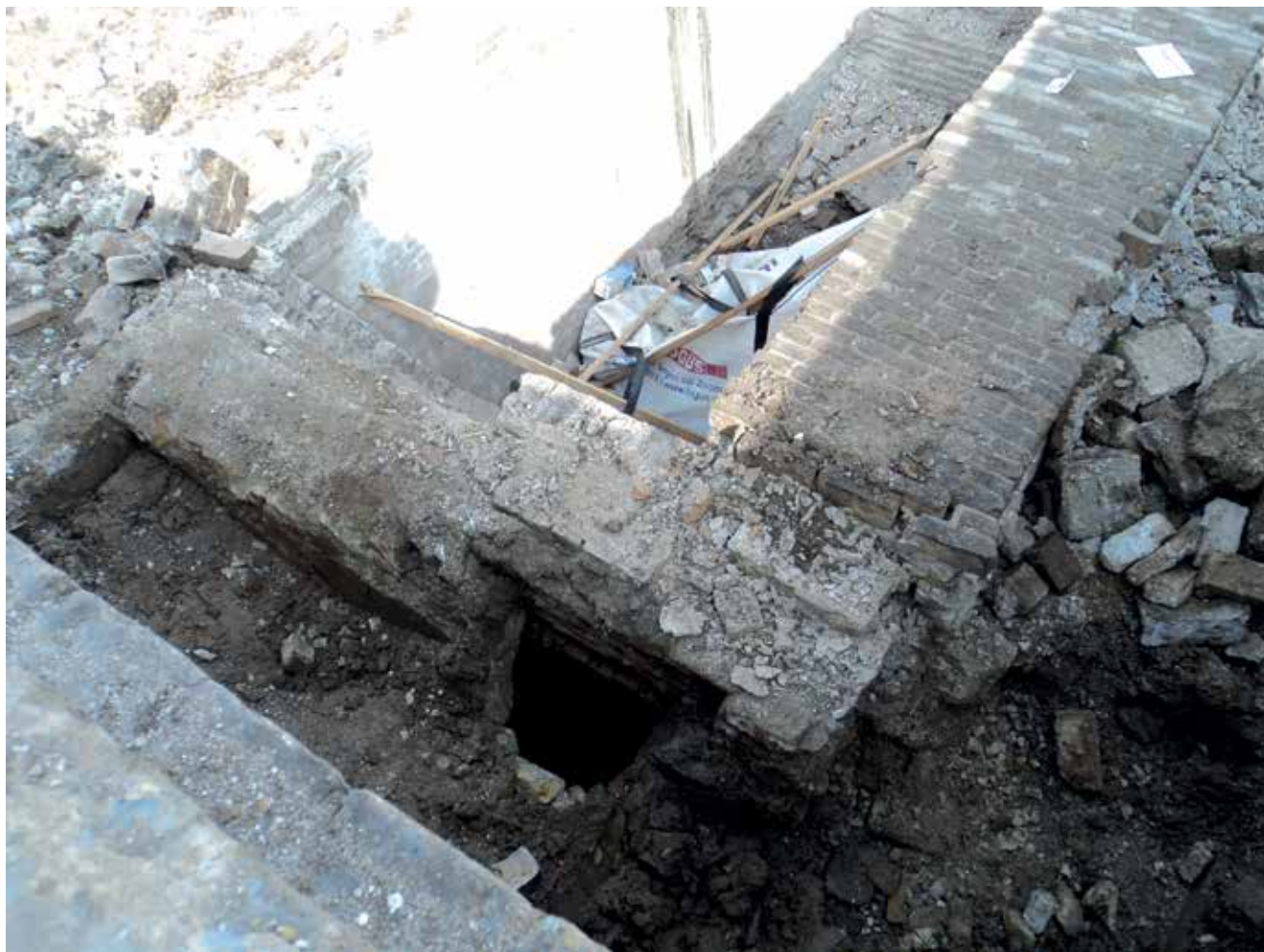
Afb. 5. Het gat naast de wielbak (foto: J. Meerburg).
