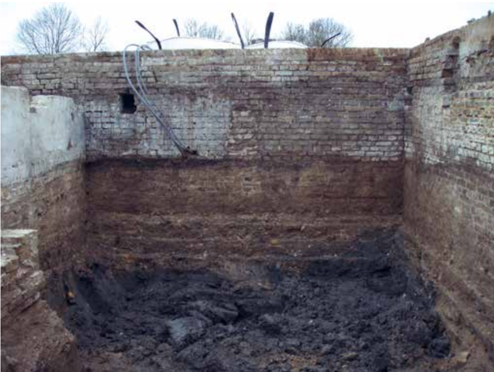
Afb. 19. Zuidwestelijke binnenzijde van de fundering. Van een gefaseerde ophoging van de fundering lijkt geen sprake.
