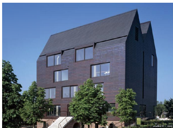
Op dezelfde locatie werd in 2007 een nieuw pand gebouwd, geïnspireerd op het verleden.
