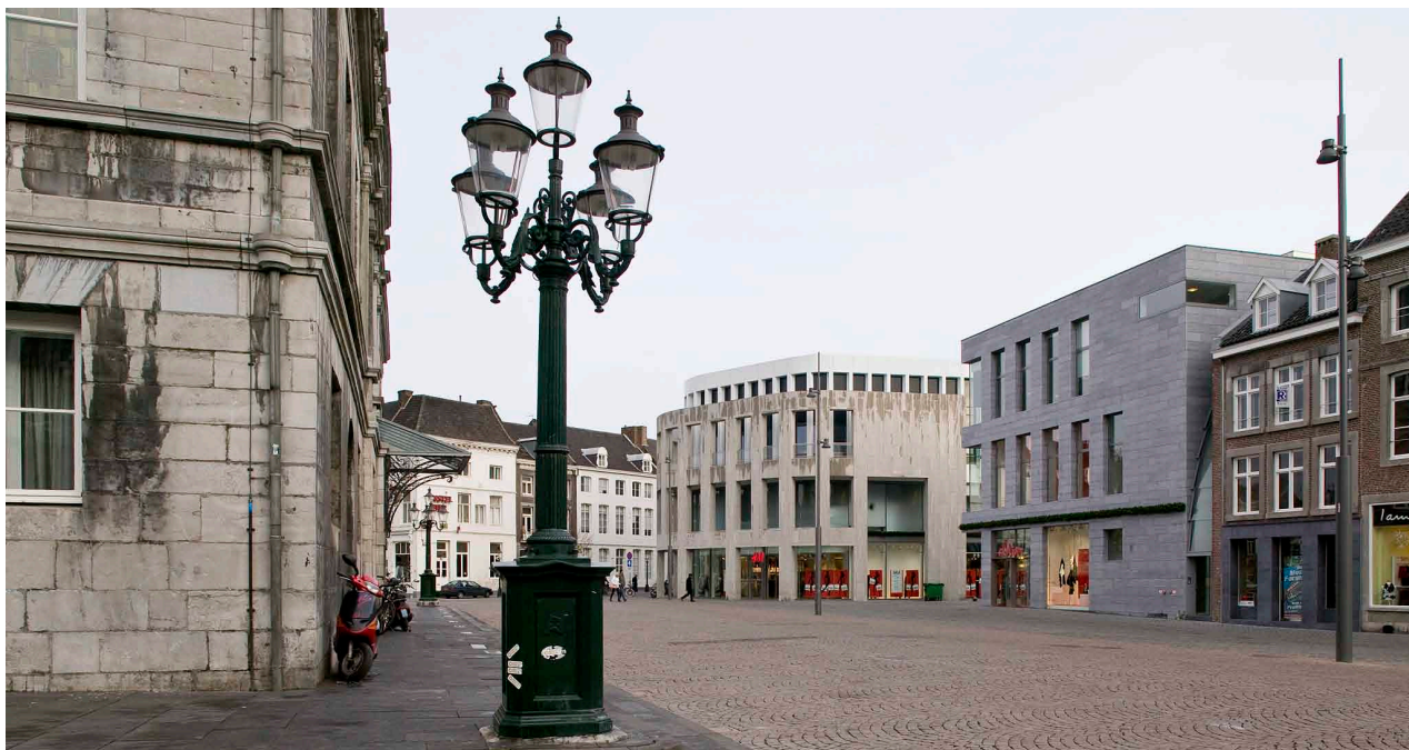
De nieuwbouw van het moderne winkel- en kantorencomplex Mosae Forum sluit goed aan bij het besloten karakter van de Markt van Maastricht
