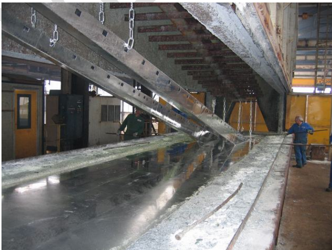
Figuur 9.6: Thermisch verzinken van een deelbare roede in 2007
