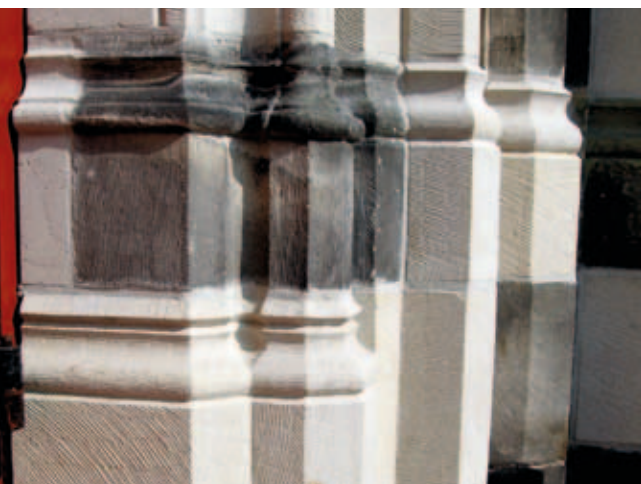
Bij de vervanging in 2010 van blokken van de Joriskerk in Amersfoort is de steenhouwer gevraagd om de bewerking aan te laten sluiten bij het oude werk. Hij is daar aardig in geslaagd
