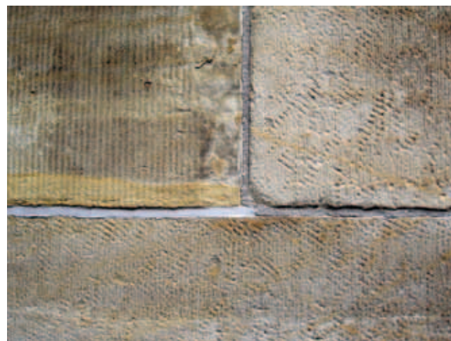
Het blok linksboven in de gevel van het stadhuis van Leiden is oud. De andere twee zijn rond 1934 vervangen. Op het oude blok is alleen een frijnslag zichtbaar. De nieuwe zijn ook nog met een tandijzer bewerkt
