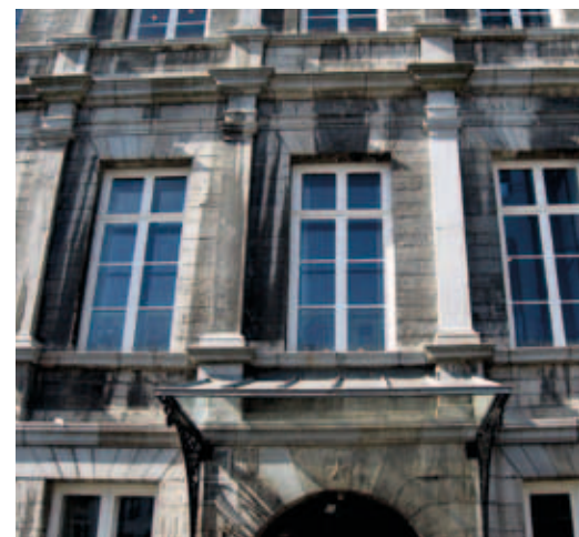
De oude pilasters links van het Maastrichtse stadhuis en de nieuwe rechts hebben een verschillend oppervlak door de wijze van bewerken
