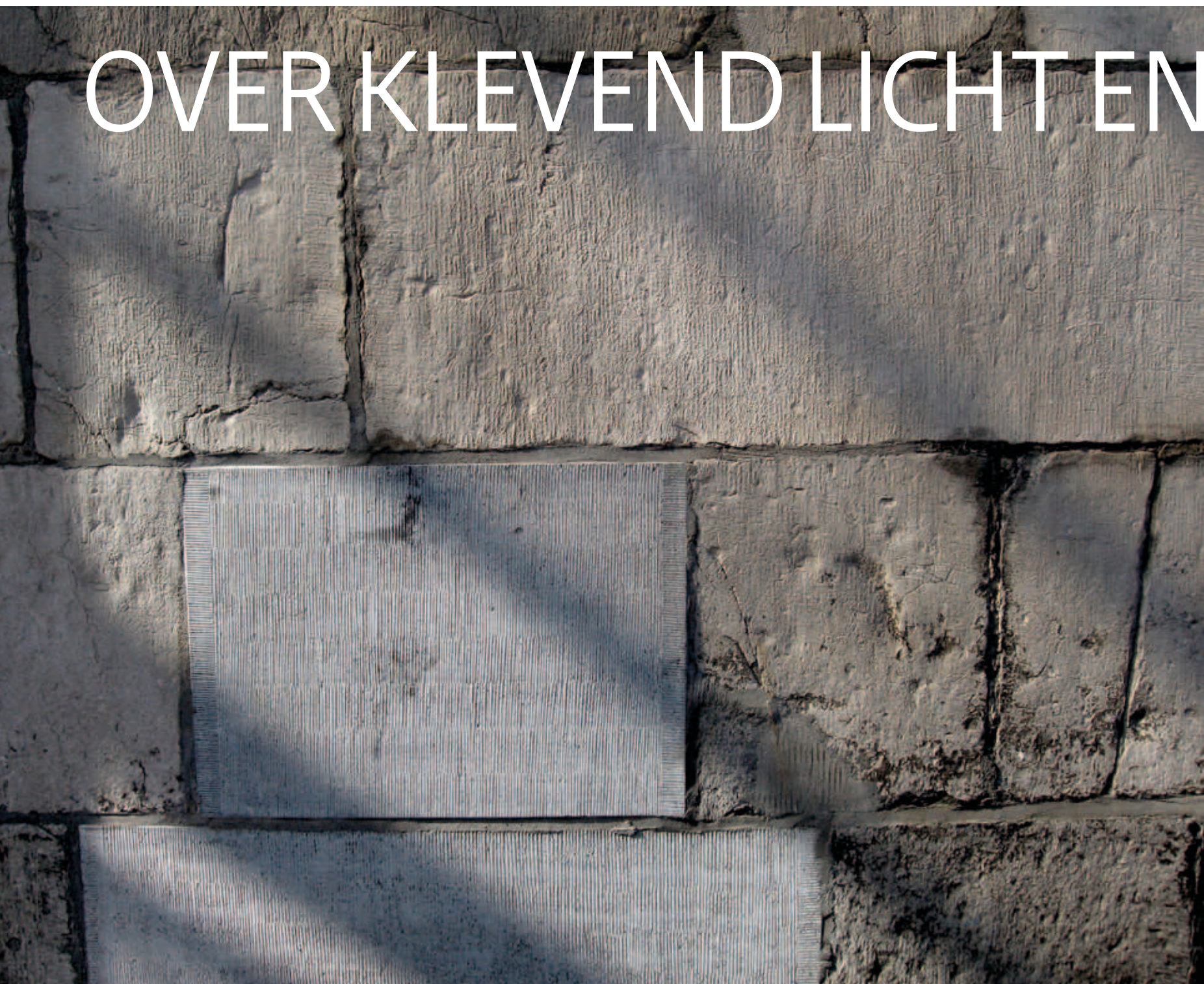
De oude en nieuwe blokken van het stadhuis van Maastricht zijn duidelijk verschillend. De nieuwe missen oneffenheden die kenmerkend zijn voor het handwerk
