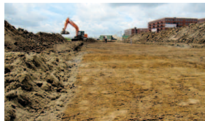
Terwijl van rechts de nieuwe huizen in sneltreinvaart oprukken, wordt het terrein vlakdekkend opgegraven
