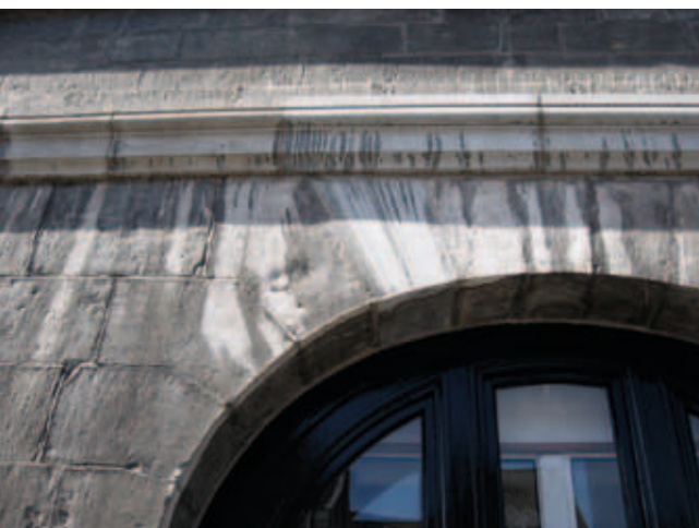
De verwerking van de blokken van het stadhuis van Maastricht, in dit geval de donkere afzetting van een gipskorst, geschiedt bij een gezaagd vlak anders dan bij een handmatig gehakt vlak
