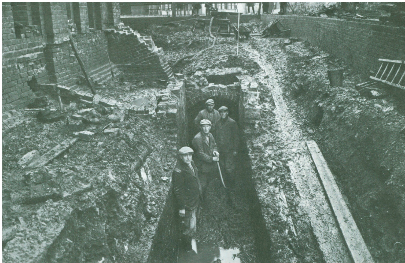
Afb. 10 Het ten noorden van de voormalige ziekenzaal gevonden afvoerkanaal tijdens de door Van Giffen geleide opgravingen (naar: Praamstra & Boersma 1977).
