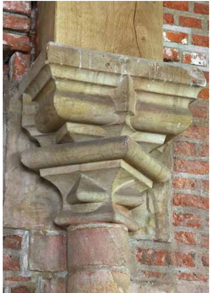
127 Kapiteel met geometrische vormen hoog tegen de westwand van het noordtransept.
