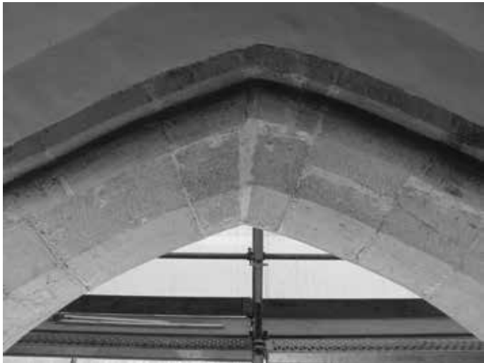
72 De onregelmatige vorm van de sluitstenen van de scheibogen in het koor laat goed zien dat ze passend zijn gemaakt bij het sluiten van de boog.
