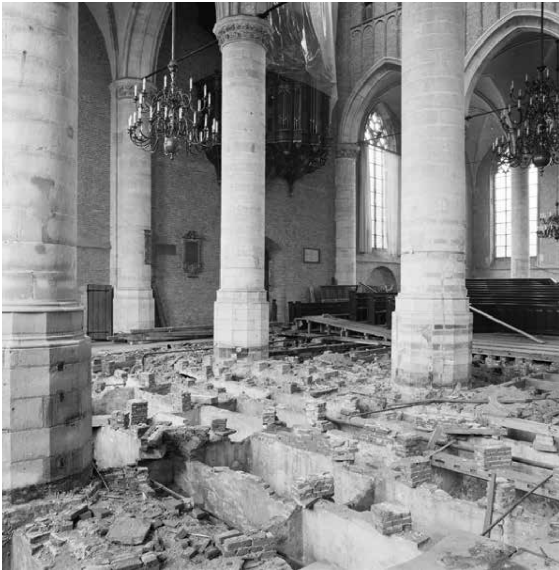
35 Grondwerk in 1980. Voorafgaand aan het aanbrengen van de betonlaag met vloerverwarming van de vloer werd in haast 'archeologisch onderzoek' uitgevoerd (Leiden, Regionaal Archief).
