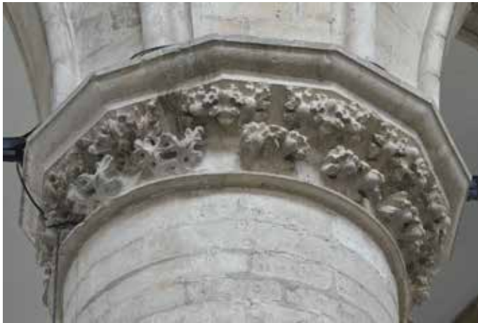
121 Schiparcade, kapiteel op dikker type kolom.
