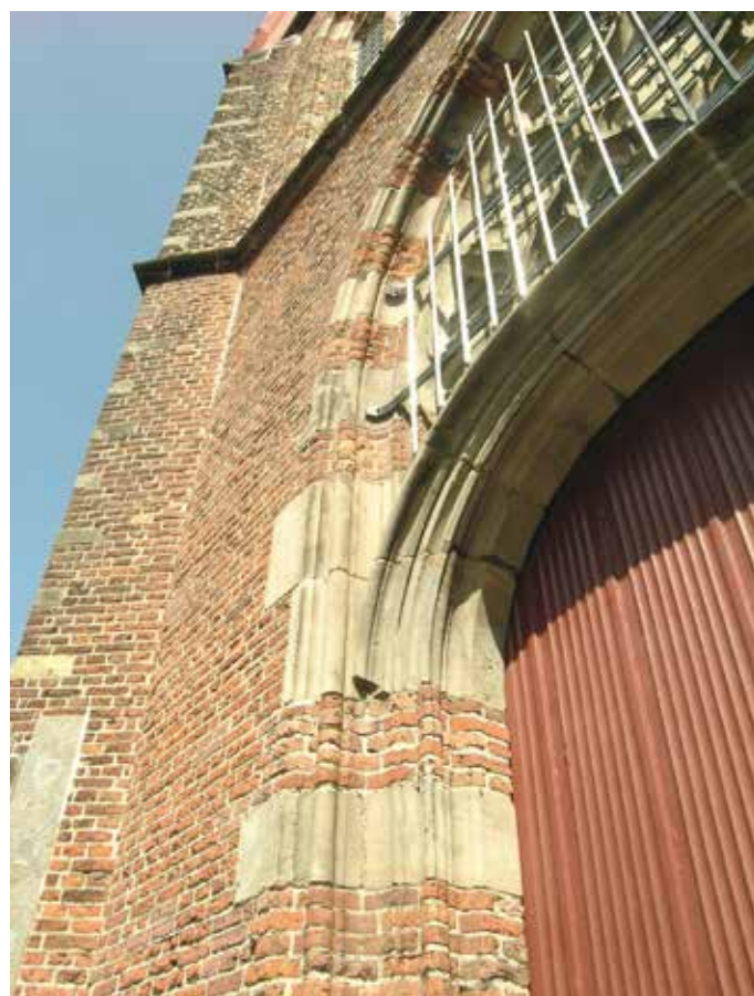
63 Detail van het westportaal. De buitenste kraal van het profiel breekt bij de aanzet van de korbboog af.
