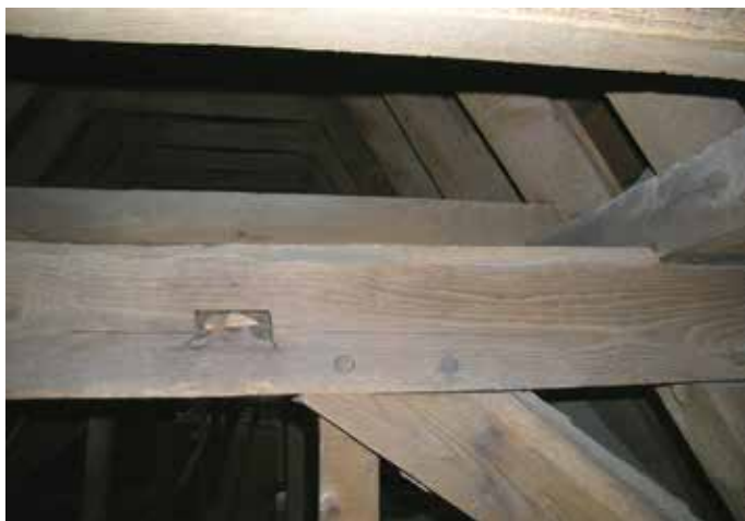
30 IJzeren nokje in een dekbalk van de kapconstructie van het hoogkoor. Waarschijnlijk is dit het restant van een takelwerktuig uit de bouwtijd.
