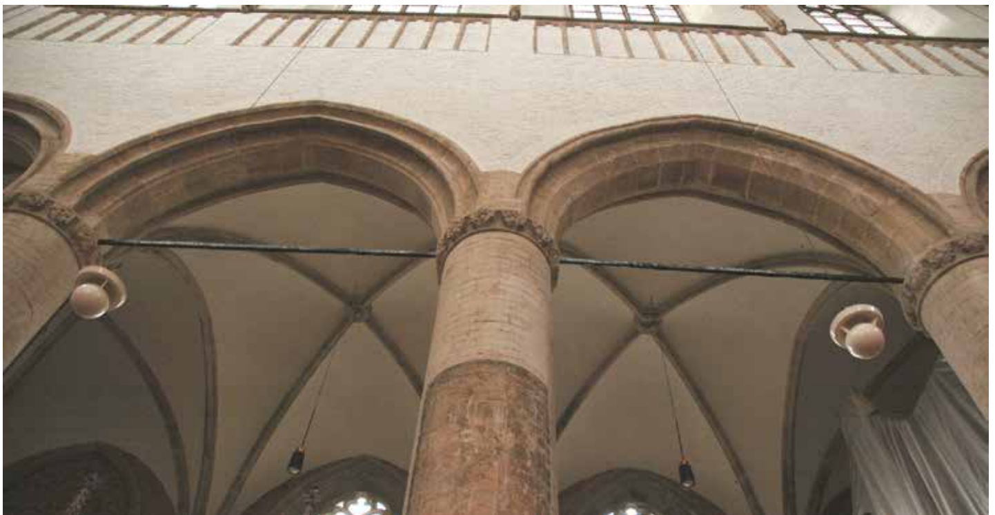
73 Scheibogen in het koor met verschillende profileringen.
