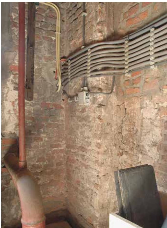
57 De hoek die de buitenzijde van de schipmuur met de westmuur vormt. Hier bevindt zich een liseen die aan de zuidzijde een tegenhanger heeft. Opvallend zijn de veel kleinere baksteen en tienlagenmaat (54 cm tegen 65 à 67 cm) dan bij het aansluitende schipmetselwerk.
