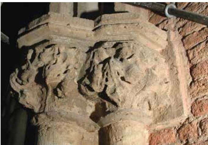
98 en 99 Kapitelen van de wandkolonnetten aan de zuidzijde van de kooromgang.
