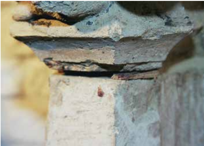
88 Kapiteel 3 bleek niet goed aan te sluiten op de schalk; de leegte aan de rechterzijde was opgevuld met een houten wigje.
