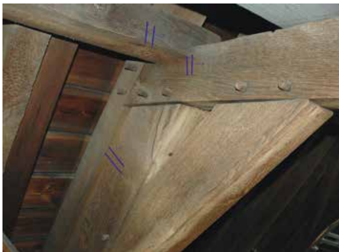
31 Driemaal het telmerk ||, op de foto met blauw geaccentueerd, op het tweede hoofdspan van de schipkap uit circa 1425. Dergelijke merken werden consequent aangebracht om in de werkplaats op maat gemaakte onderdelen in de kap op de juiste plaats te verwerken.
