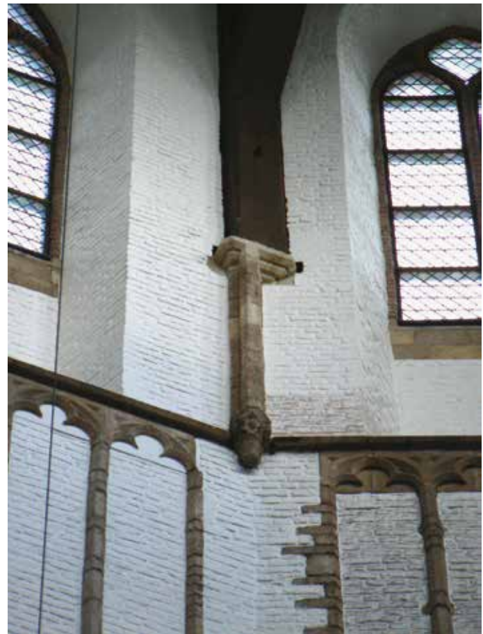
71 Kolonnet in de lichtbeuk van het koor.
