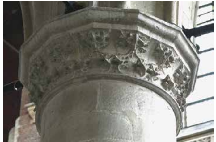
124 Arcade zuidtransept, westzijde: kapiteel op de kolom direct ten zuiden van de vieringpijler.
