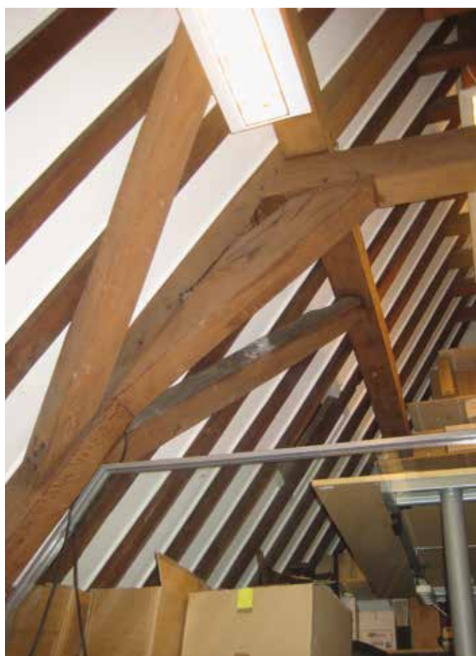
149 Detailopname van de kapconstructie.
