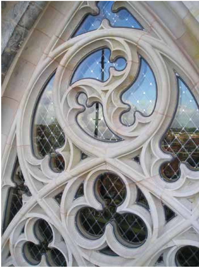
8 Een deel van het door de firma Slotboom vernieuwde venster in de kopgevel van het noordtransept (2006).
