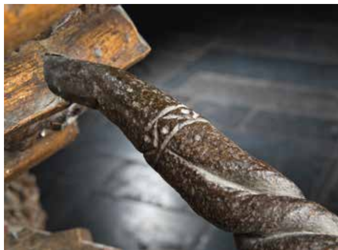
75 Detail van de handlijst. Het smeedwerk in brons is oorspronkelijk en stamt dus uit het tweede kwart van de 16de eeuw.
