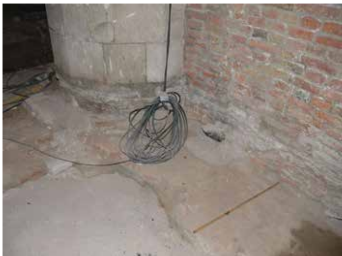
54 De westmuur van het middenschip is onderaan 150 cm dik. Net onder de huidige vloer is de muur circa 75 cm dikker. Dit was in 2008 waar te nemen, maar door de betonvloer konden de in 1980-1981 opgetekende gegevens slechts ten dele worden geverifieerd en aangevuld.
