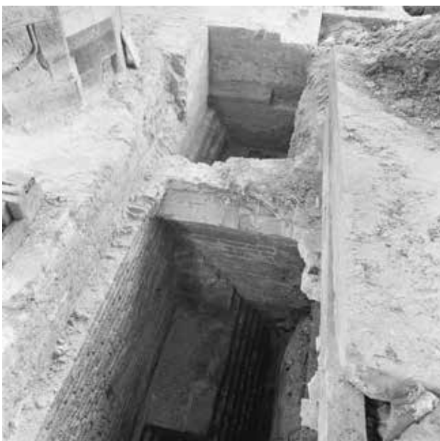
13 Een graf en een daarvoor weggehakte versnijding van een funderingsstrook tussen de twee zuidelijke pijlers van de viering, dichtbij het koor. Dit stuk fundering droeg sinds de voltooiing van het transept in het tweede kwart van de 16de eeuw niets meer, want er was een kolom tussen de pijlers weggehaald. Nadien kon men er dus vrij risicoloo in hakken. Foto Dukker, circa 1980 (Amersfoort, Rijksdienst voor het Cultureel Erfgoed).
