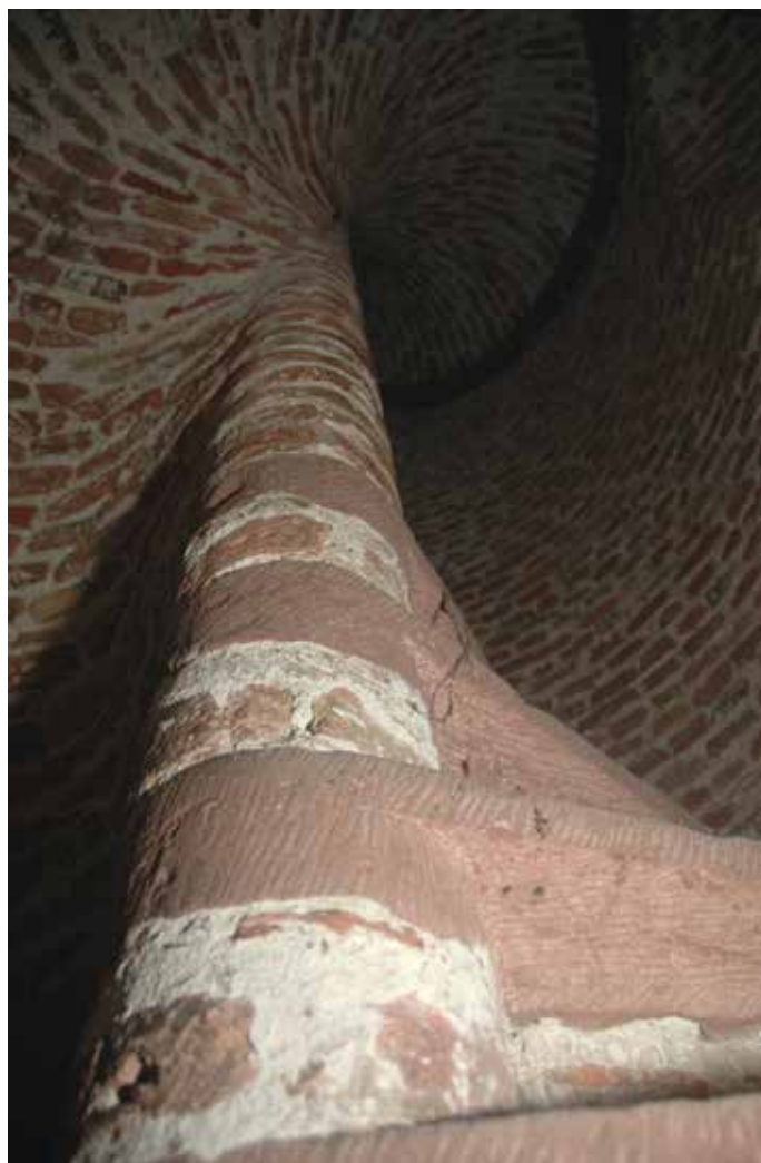
2 De trap in de noordelijke van de twee traptorens van de westpartij. De traptreden in de onderste helft van beide torens zijn van rode zandsteen.
