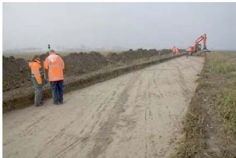
Afb. 3 Een blik in werkput 1 (januari 2009).
