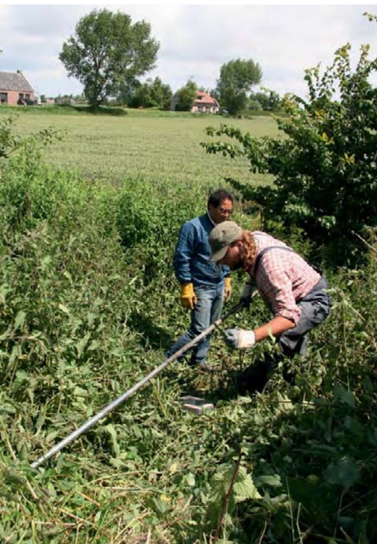
Afb. 26 De veldsituatie aan de Zoutlandse dijk.
