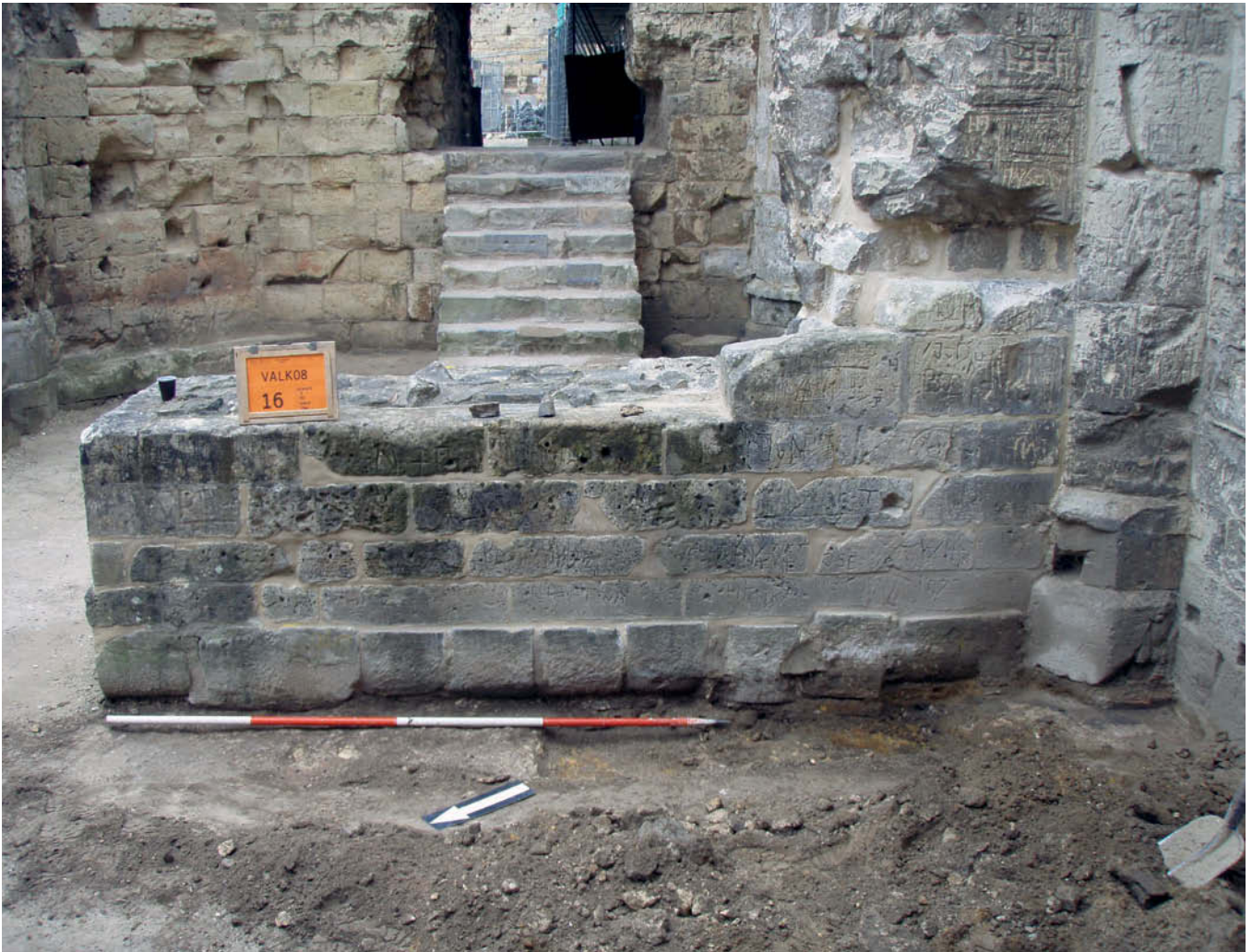
Afb. 42 De binnenmuur in de kapel ter hoogte van put 3, genomen naar het zuiden.
