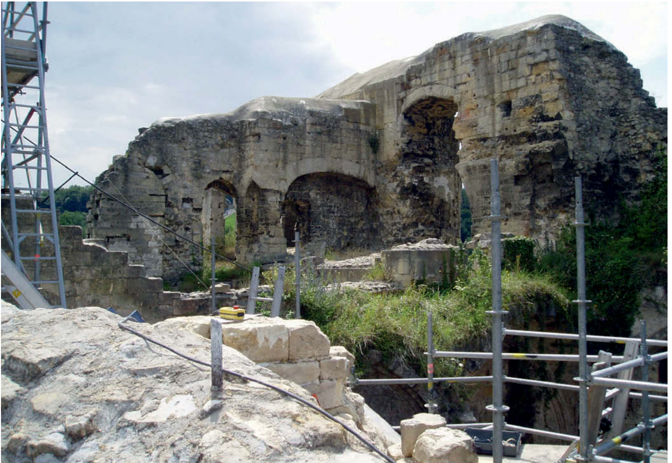
Afb. 9 De restauratie- en consolidatiewerkzaamheden rond de Grote Zaal in 2007 in volle gang.
