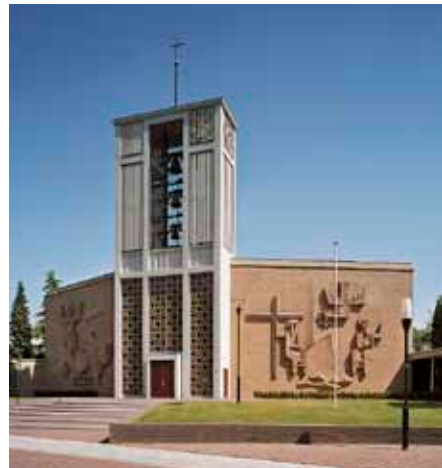
De westgevel van de Heilige Theobaldus en Antonius van Padua in Overloon, met gevelversiering en met de opengewerkte betonnen klokkentoren
