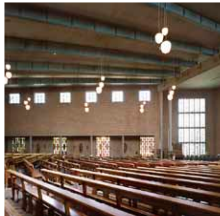
Stalen spanten lopen taps naar het koor in de Heilige Theobaldus en Antonius van Padua te Overloon
