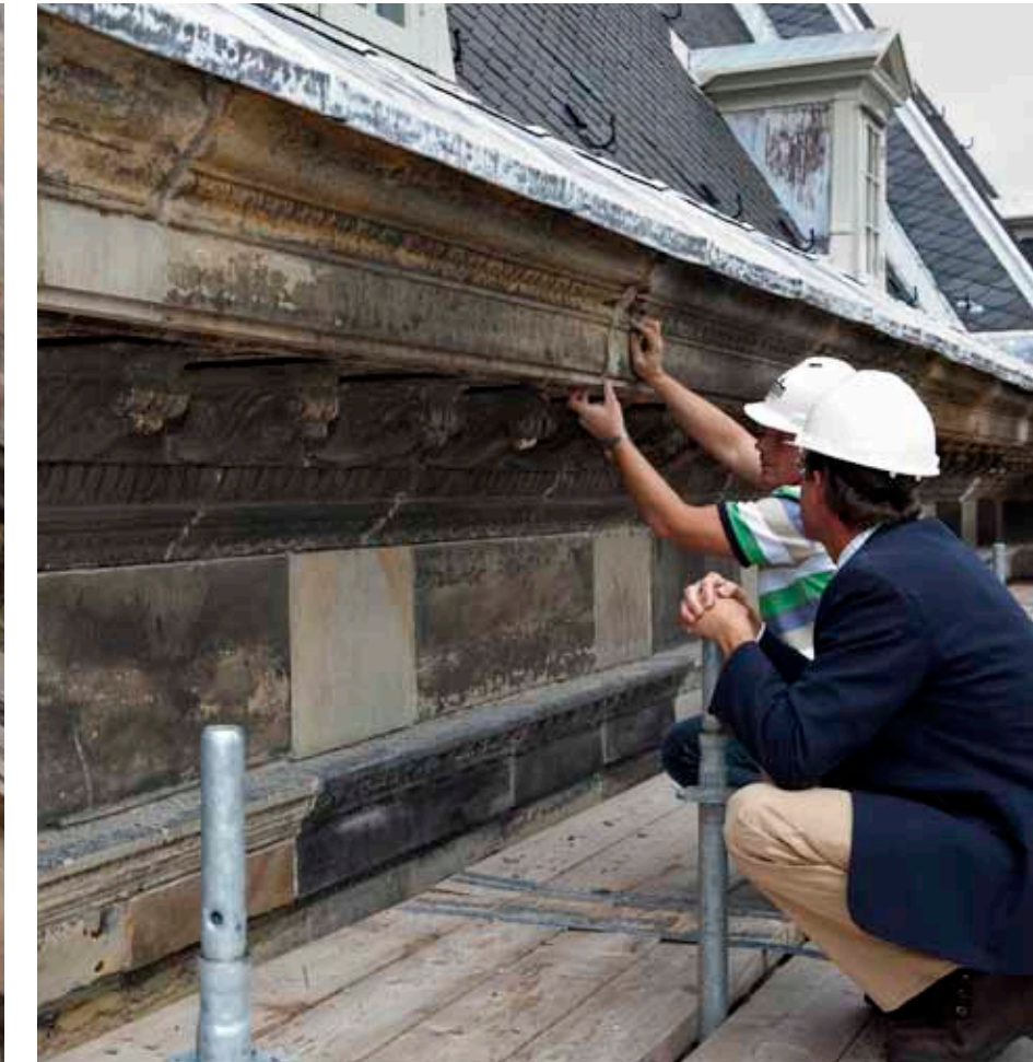
Het fries onder de kroonlijst heeft door het vervangen van blokken steen een zebra patroon gekregen. Dit was helemaal niet de bedoeling
