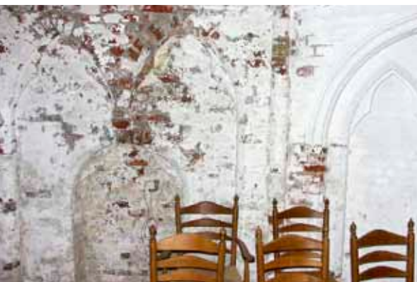
Schade door vocht en zouten aan de witte kalklaag in het koor, voor de restauratie
