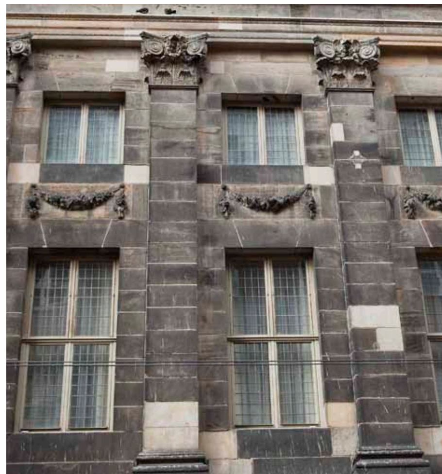
Het linker hoekpaviljoen, gezien vanuit de Paleisstraat. De lichte blokken vallen uit de toon
