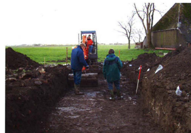
Afb. 4 Aanleg van de sleuf in Kenwerd voorafgaande aan het plaatsen van de heipalen.
