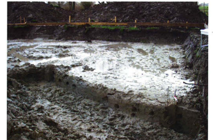
Afb. 5 Sleuf in Groot Wetsinge nadat de heipalen – herkenbaar aan de uitstekende ijzers van de bewapening met veiligheidslint – waren geplaatst.
