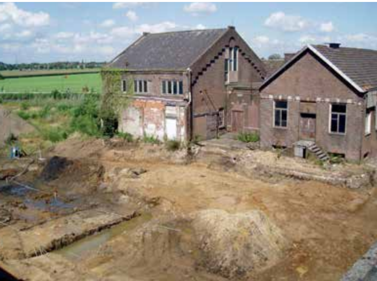
Afb. 19 Ketelhuis met machinekamers en pompinstallaties.
