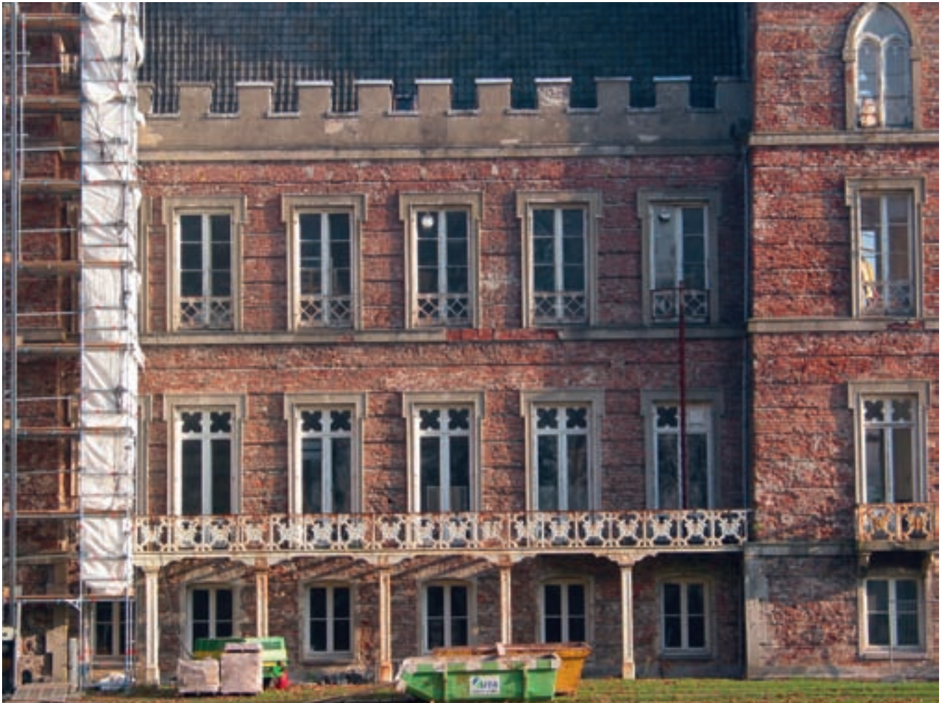
Bij de restauratie van kasteel Beverweerd werden na verwijdering van de pleisterlaag veel bouwsporen van een vorige verbouwing weer zichtbaar. Foto: Albert Reinstra
