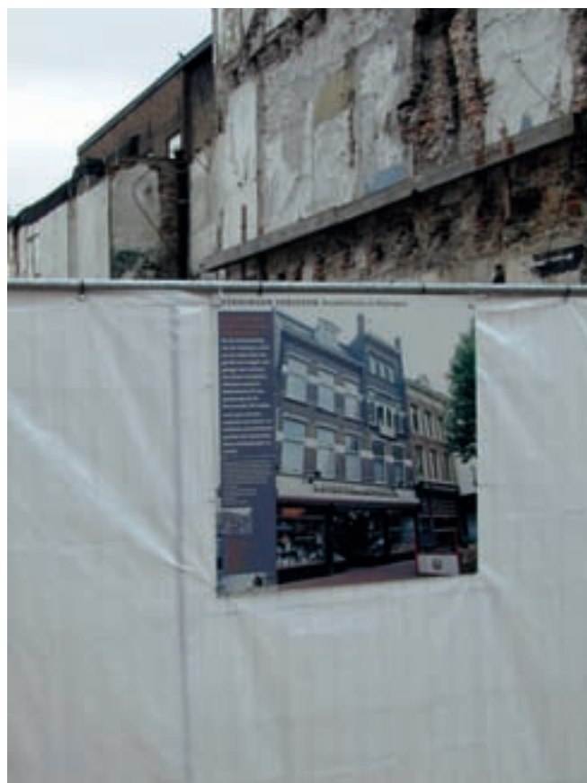
Tijdens de sloop van dit pand aan de Nijmeegse Molenstraat werden de voorbijgangers geïnformeerd over de bouwgeschiedenis hiervan. Foto: Albert Reinstra.
