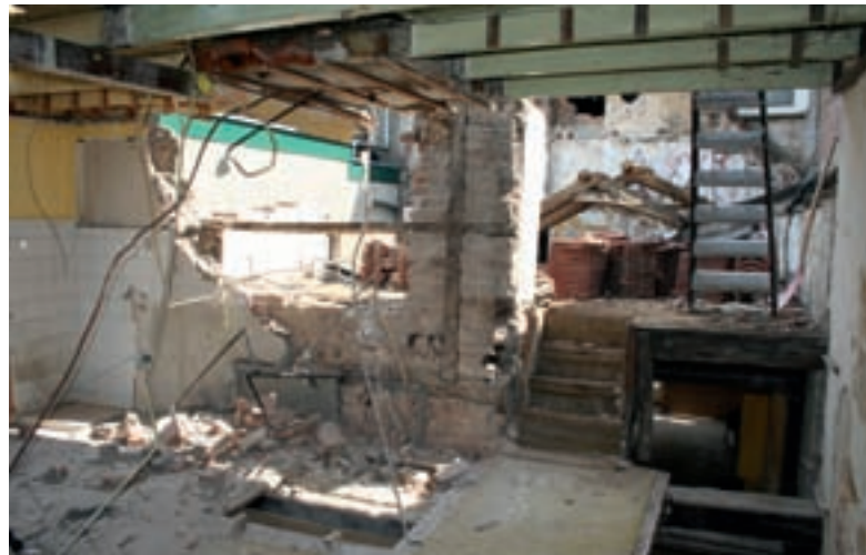
Bouwhistorische documentatie tijdens sloop. Achterhuis van Laarstraat 59 te Zutphen met vakwerk dendrochronologisch gedateerd ca. 1499. De gebintrestanten op de achtergrond zijn gedateerd ca. 1640-45. Foto: Jeroen Krijnen, gemeente Zutphen.
