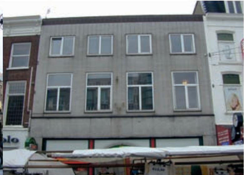
Maar ook achter deze weinig interessante twintigste-eeuwse gevel in Nijmegen bleek bij bouwhistorisch onderzoek een veel ouder pand schuil te gaan. Foto: Albert Reinstra.
