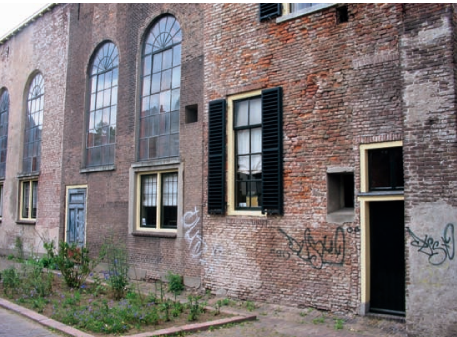
De bouwsporen aan deze gevel aan de Armenhage in Zutphen laten zien dat dit pand in de loop der eeuwen regelmatig is gewijzigd. Foto: Gerhard Eshuis.
