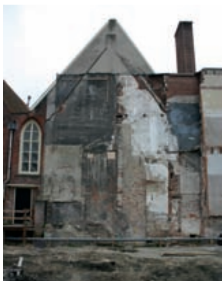
De achterzijde van de Waalse kerk, Breestraat 62 te Leiden. In de gevel is de tuitgevel van de verdwenen koorpartij zichtbaar, met daarin de open triomfboog tussen koor en schip. De tekeningen verduidelijken de verschillende bouwsporen. Herkomst: Unit Monumenten en Archeologie, gemeente Leiden.
