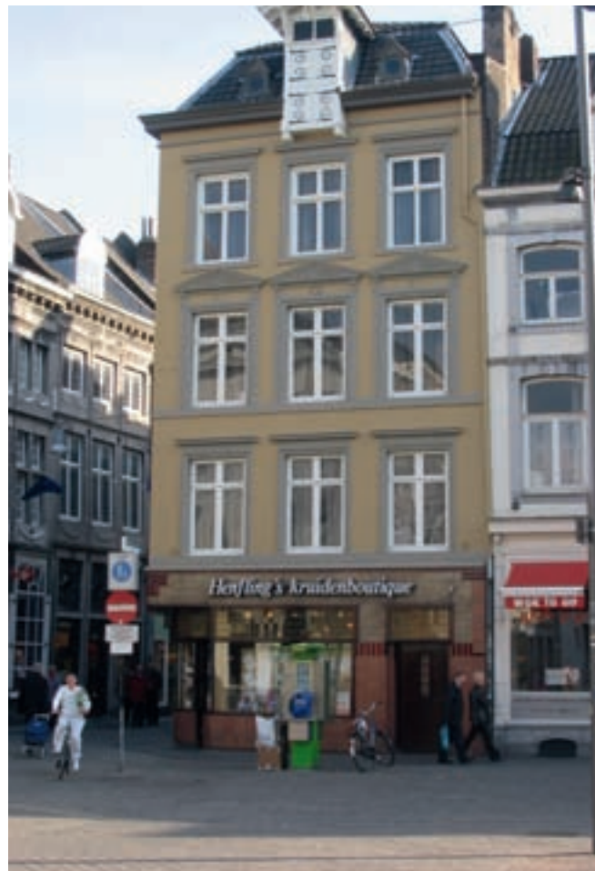
Via bouwhistorisch onderzoek konden de oorspronkelijke kleuren aan de gevel van dit pand aan de Markt in Maastricht weer in ere worden hersteld.
