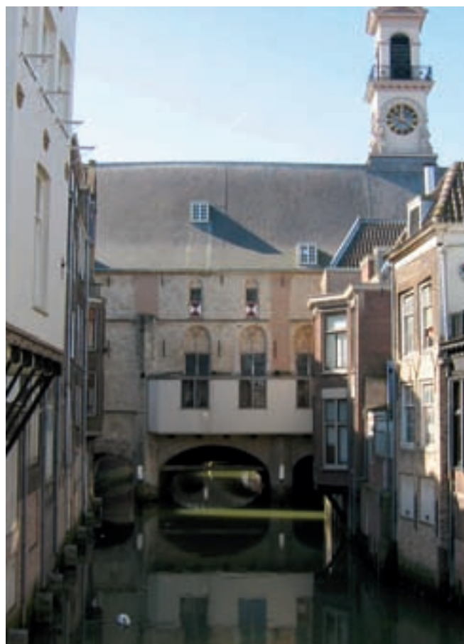
Dankzij de tijdens de restauratie ontdekte bouwsporen kon de middeleeuwse achtergevel van het Dordtse stadhuis weer gedeeltelijk worden gereconstrueerd. Foto: Floris Eshuis.
