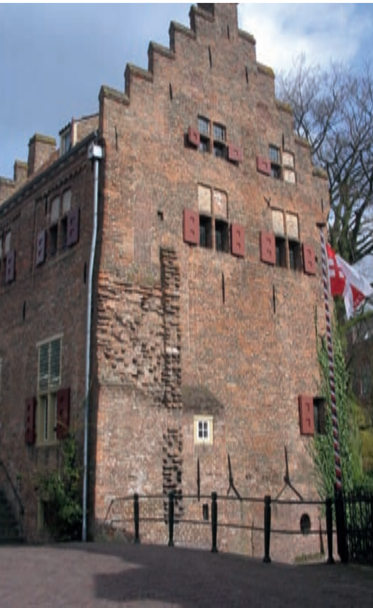
Aan het Amersfoortse huis Oud Tinnenburg zijn de restanten van de voormalige waterpoort in de gesloopte stadsmuur nog goed zichtbaar. Foto: Gerhard Eshuis.
