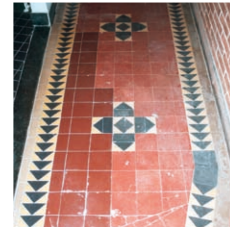
Inboetingen aangebracht tijdens renovatiewerkzaamheden met moderne, sterk detonerende vloertegels
