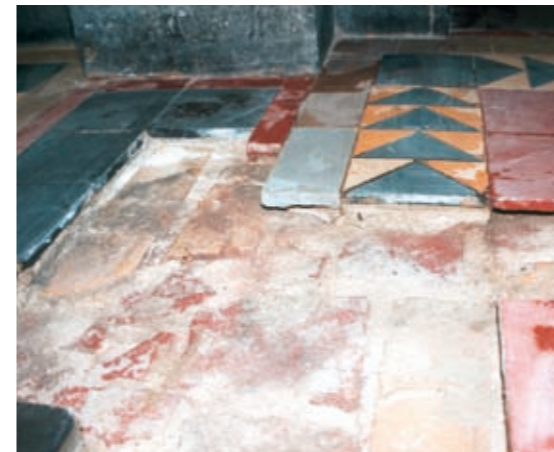
Herstelproefstuk tijdens onderzoek naar de samenhang tussen constructie en mortelbed
