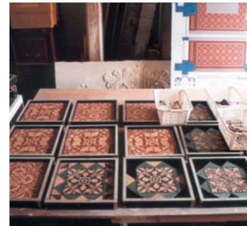
Het nauwkeurig samenstellen van vierkantvlakken met oorspronkelijke en replicategels tijdens de restauratie van patroontegelvloeren in de Maria van Jessekerk te Delft, 2007
