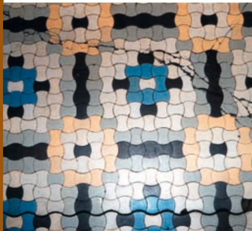
Deze krakelingenvloer heeft z'n glans niet verloren, maar is door constructieve gebreken letterlijk gekraakt
