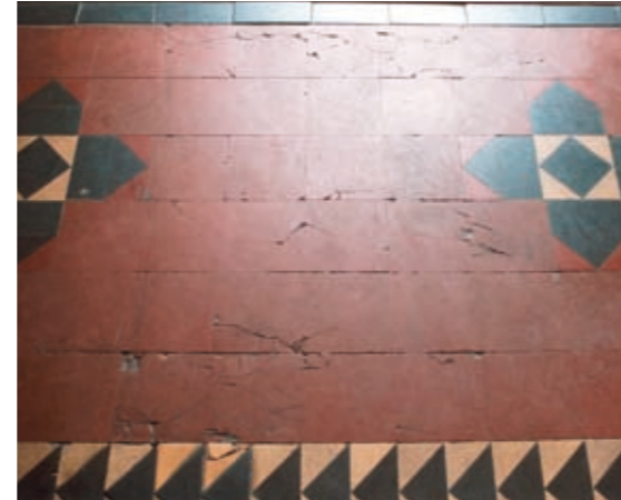
Tegelschade als gevolg van kapotlopen en transportbelastingen
