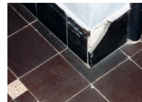
Het afboeren van hoeken is vaak het gevolg van transportmiddelen
