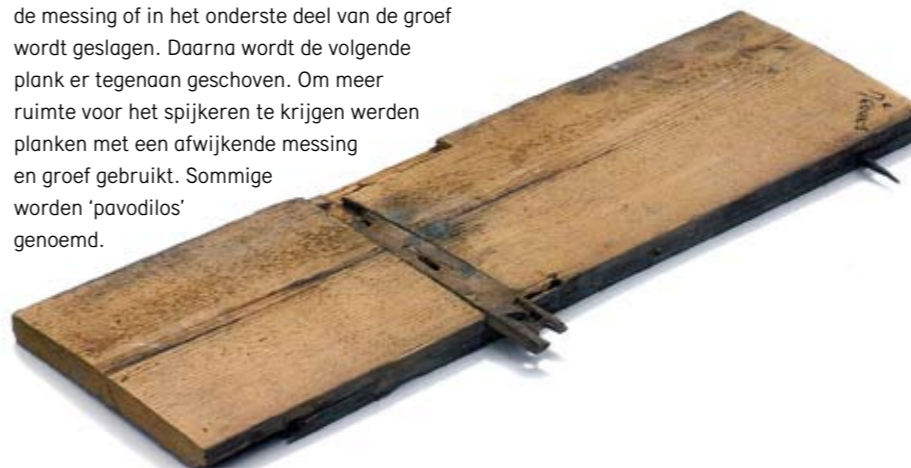
Onderaanzicht van een zeventiende-eeuwse plank. Links van het midden is een wig zichtbaar, die op de balk gespijkerd wordt. Door de plank over de wiggen te schuiven wordt de plank, 'blind' en zonder te spijkeren, aan de balken bevestigd. Geheel rechts op de foto een ijzeren pin, waarmee de planken onderling met elkaar worden verbonden (foto RACM)
