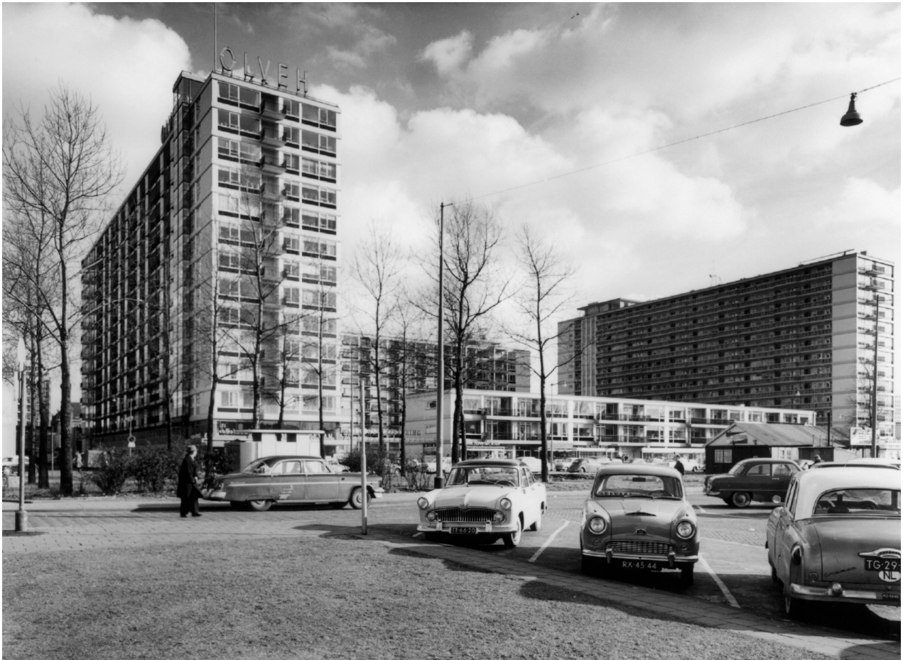
overzicht woonhof Lijnbaanensemble vanaf Schouwburgplein in jaren '50/ '60 (GAR)
