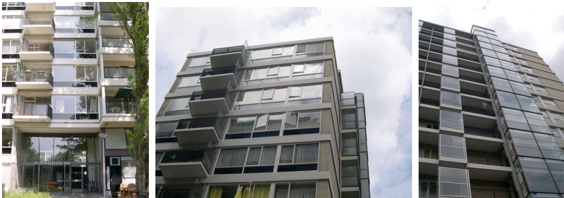
doorgaande betonbanden en uitspringende balconen en glaspartijen (RACM)
