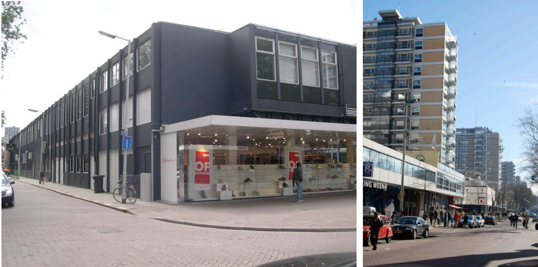
Joost Banckertplaats en Karel Doormanstraat als voor- en achterzijde van de woonhoven (RACM)
