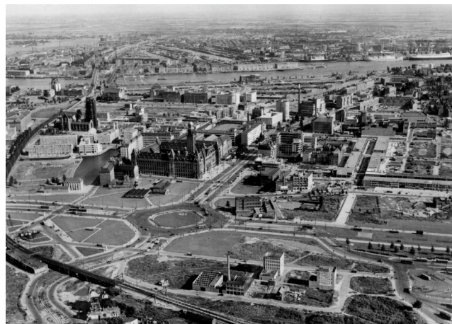
luchtfoto Coolsingel en Lijnbaan in aanbouw (GAR)
