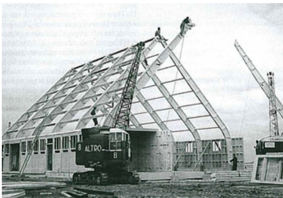
AFBEELDING 4.10 MONTAGE VAN EEN SCHOKBETONNEN SCHUUR TUSSEN MARKNESSE EN EMMELOORD (NOP) 1949
