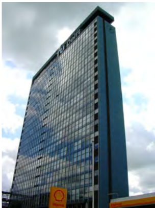
AFBEELDING 3.2 GEBOUW VOOR ELEKTROTECH- NIEK, DELFT.
