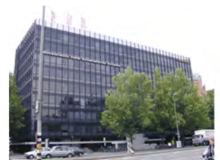
AFBEELDING 3.6 DIT KANTOORPAND WERD IN 1971 GEHUURD TEN BEHOEVE VAN DE HUISVESTING VAN DE FACULTEIT PSYCHOLOGIE. HET KREEG DE BIJNAAM 'DE DOODSKIST', VANWEGE DE DONKERE GLAZEN GEVELS.
