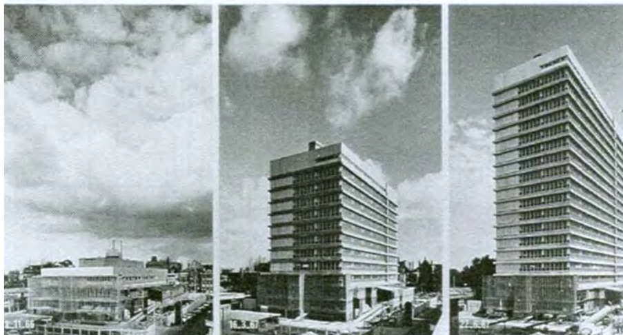
Drie stadia van de vijzeling van het Transitorium, Den Haag, 1966-'67, Bart Hofmeester (HBG Bouw en Vastgoed BV, Collectie J.A.A.M. Vollebregt).
