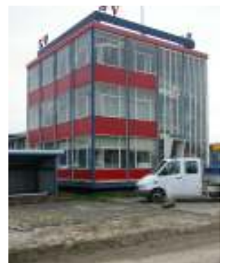
AFBEELDING 4.3 STAALBOUW VIANEN TE VIANEN, ARCHITECT A. VAN DE GRAAFF, 1961.
