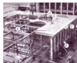
AFBEELDING 3.24 EXPERIMENTELE CONSTRUCTIE BIJ DE FABRIEK VAN N.V. VAN DE HEEM IN DEN HAAG.
