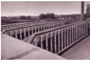
AFBEELDING 3.31 HOUTEN SHEDDAKCONSTRUCTIE IN VEENENDAAL, NEMAHO.
