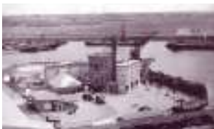
AFBEELDING 3.4 BETONMORTELCENTRALE BEFARO IN ROTTERDAM, EEN ONTWERP VAN DE GEBR. KRAAIJVANGER.
