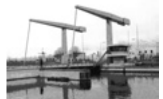
AFBEELDING 4.9 SCHROEFBRUG O/H KANAAL DOOR WALCHEREN, MIDDELBURG (1969). DEZE BRUG IS GEHEEL GELAST.
