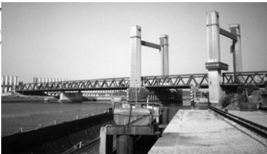
AFBEELDING 4.1 CALANDBRUG (1 EEN GEHEEL GE CONSTRUCTIE M HEFTORENS
