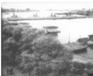
AFBEELDING 3.2 'BRUG' OVER HET IJ IN AMSTERDAM
