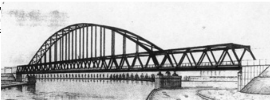
AFBEELDING 4.7 SPOORBRUG O/H RIJNKANAAL, DE (1965)
