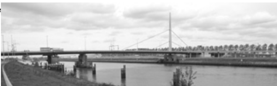
AFBEELDING 4.5 DE BRUG OVER HARTELKANAAL BRUG) (1964)
