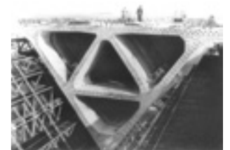
AFBEELDING 4.33B NABLALIGGER (IN AANBOUW)
