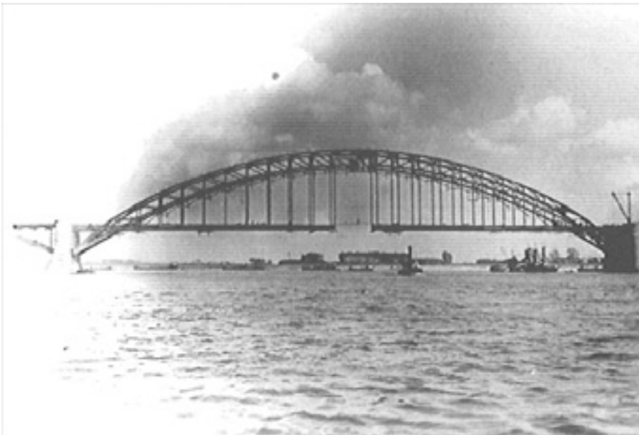
AFBEELDING 3.4E WAALBRUG BIJ NIJMEGEN, BRUG WEER VOLTOOID: SITUATIE 1941
