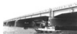
AFBEELDING 6.3 MAASBRUG TE ROERMOND
