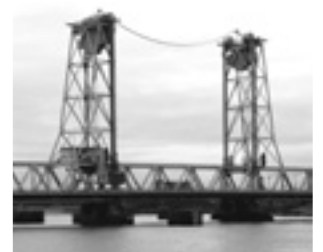
AFBEELDING 4.9 SCHROEFBRUG O/H KANAAL DOOR WALCHEREN, MIDDELBURG (1969). DEZE BRUG IS GEHEEL GELAST.
