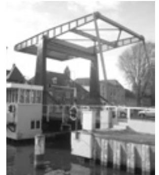
AFBEELDING 4.8 HINTHAMERBRUG O/D ZUID- WILLEMSVAART TE DEN BOSCH: 1947 GERENOVEERD. DEZE BRUG IS NOG GEHEEL GEKLONKEN.
