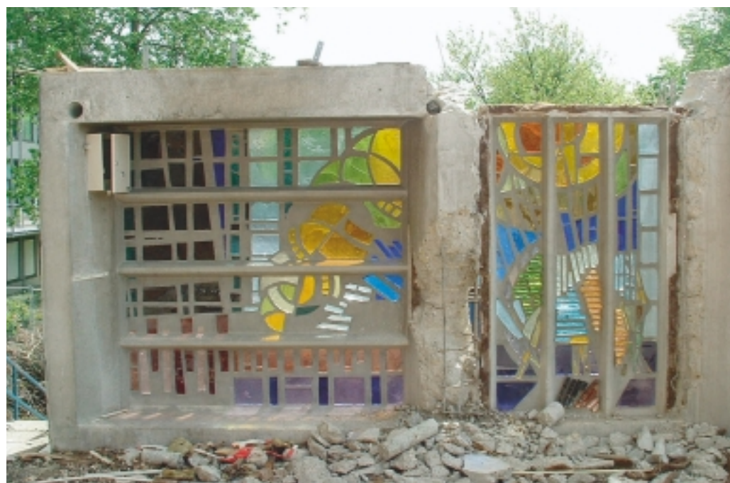
Glas-in-beton, gemaakt door stukken dalle de verre in beton te gieten. Deze relatief jonge kunstvorm is door zijn onbekendheid erg kwetsbaar. De panelen op de foto zijn inmiddels gerestaureerd (foto EGM architecten)
