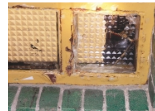
Prismategels, vermoedelijk van Luxfer, in een daklicht in het jacht-slot Sint Hubertus in Otterloo op de Veluwe (foto Michiel van Hunen)
