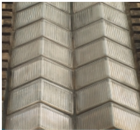
Geknikte glazen bouwstenen van Vera-Lux, waarvoor Emile Sanders uit Amsterdam het Nederlandse octrooi had. Trappentiek aan de Nachtegaalstraat te Utrecht
