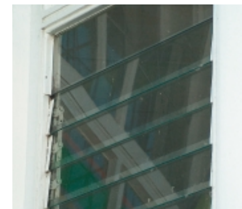
Glasjaloezieën als beter te regelen variant op ventilatieglas
