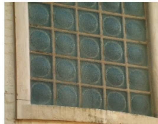
Dunne glazen Nevada-bouwstenen in de voorgevel van het dr. A.F. Philips Observatorium in Eindhoven
