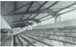
AFBEELDING 2.10 DE EERSTE TRIBUNE MET KOLOMVRIJE KAPCONSTRUCTIE WERD GEBOUWD IN HET GEMEENTELIJK SPORTPARK TE ALKMAAR (ARCHITECT J. WILS, 1929-1930).
