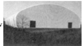
AFBEELDING 3.9 SPORTHAL SCHEEMDA, OPGETROKKEN UIT HOUT, OVERDEKT MET EEN PLASTIC HUID.
