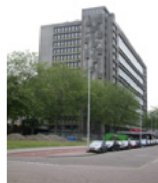
AFBEELDING 3.8 STATIONSPOSTKANTOOR EN HOOFDPOSTGEBOUW ROTTERDAM, ARCHITECTENBU- REAU KRAAIJVANGER, GEBOUWD TUSSEN 1954 EN 1959.
