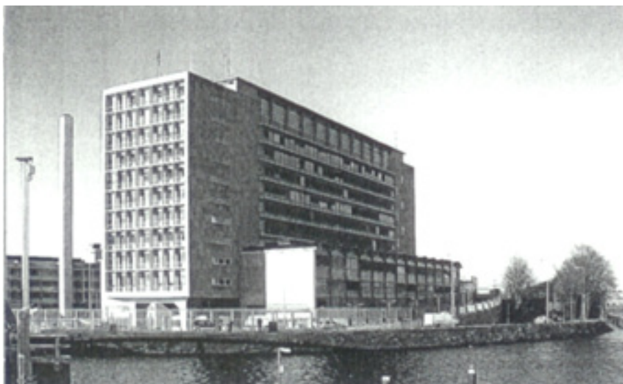
AFBEELDING 3.12 HET STATIONSPOSTKANTOOR VAN AMSTERDAM IS SINDS 2003 BUITEN FUNCTIE. DE LAAGBOUW VAN HET COMPLEX IS IN 2004 GESLOOPT. DE HOOGBOUW WORDT INGRIJPEND VERBOUWD.
