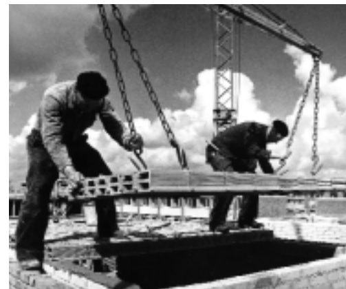
Het plaatsen van een systeemvloer (foto Wouter van Heusden)
