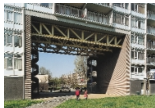
Fraaie oplossing voor de onderbreking van een lange gevel in Bilgaard, Leeuwarden
