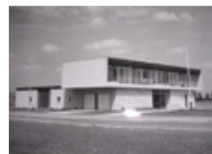
AFBEELDING 4.7 KRUISGEBOUW IN VLEUTEN VLAK NA OPLEVERING (1965)
