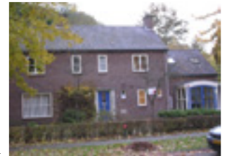
AFBEELDING 4.9 KRUISGEBOUW A.D. SCHIMMELPENNINCK V.D. OIJENLAAN TE DOORN. OPGERICHT DOOR HET ORANJE GROENE KRUIS
