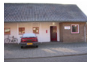
AFBEELDING 4.17 KRUISGEBOUW IN WESTDORPE
