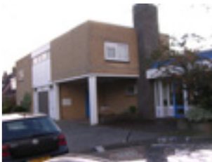
AFBEELDING 4.10 KRUISGEBOUW TE WOUDE- BERG; NOG STEEDS IN GEBRUIK ALS WIJKGEBOUW VAN DE ST. THUISZORG EEMLAND
