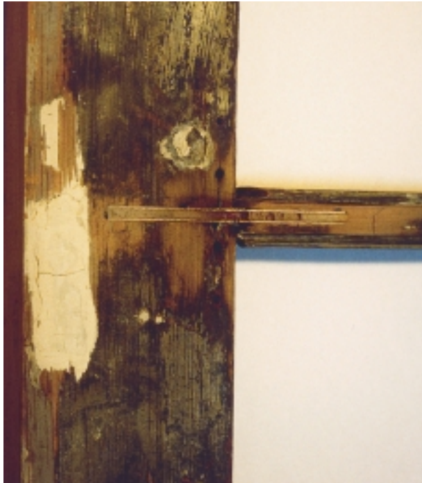
Een ingebracht pennetje dat de verbinding tussen stijl en roede weer herstelt
