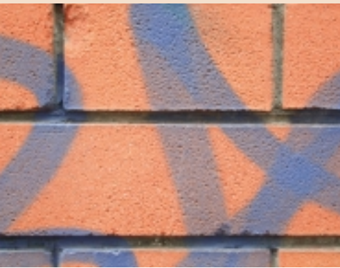
Graffiti op verblendsteen-metselwerk. De nieuwe graffiti konden diep indringen doordat eerdere graffiti onjuist waren verwijderd, waarschijnlijk met een straaltechniek (foto Michiel van Hunen)
