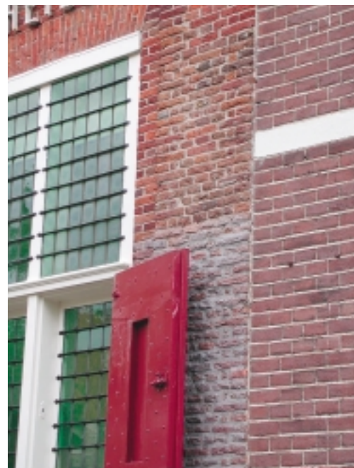
Monumentale gevel waarbij het aangebrachte anti-graffitisysteem duidelijk zichtbaar is (foto TNO Bouw)
