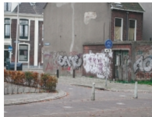
Graffiti ontsieren de openbare ruimte en kunnen bijdragen aan een gevoel van sociale onveiligheid (foto TNO Bouw)
