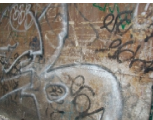
Graffiti die zijn aangebracht op een gepleisterde en geschilderde ondergrond kunnen worden verwijderd of overgeschilderd (foto Michiel van Hunen)
