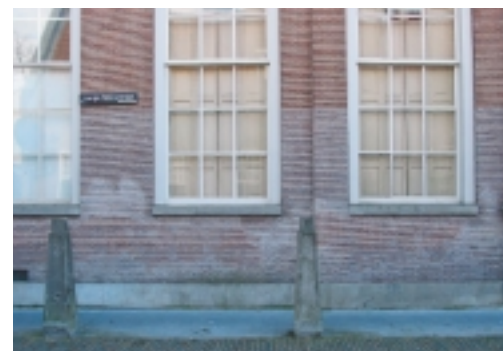
Het aangebrachte anti-graffitisysteem is storend zichtbaar. Mogelijk is door een verkeerde voorbehandeling of vocht in de ondergrond de laag wit uitgeslagen (foto Utrecht, sectie Monumenten)
