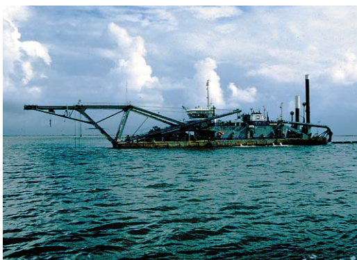
Baggerwerkzaamheden ten behoeve van de uitbreiding van de Maasvlakte.
