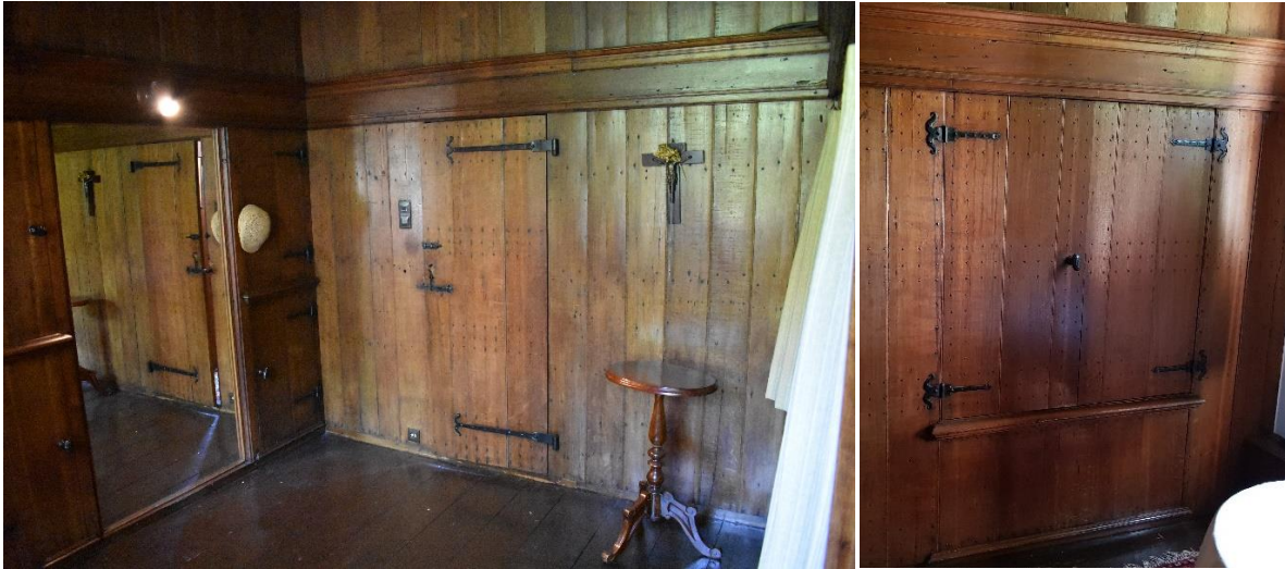
111 en 112 – Wagenschot tussenwand naar gang, met rechts de moderne spiegel | Tweedeurs bedstee met gesmede gehengen.
