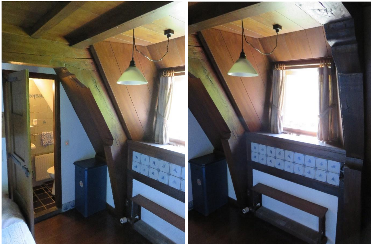
101 en 102- Recentere badkamer op locatie oorspronkelijk bedstee | Dakkapel rechter zijdakvlak met geprofileerd standbeen.
