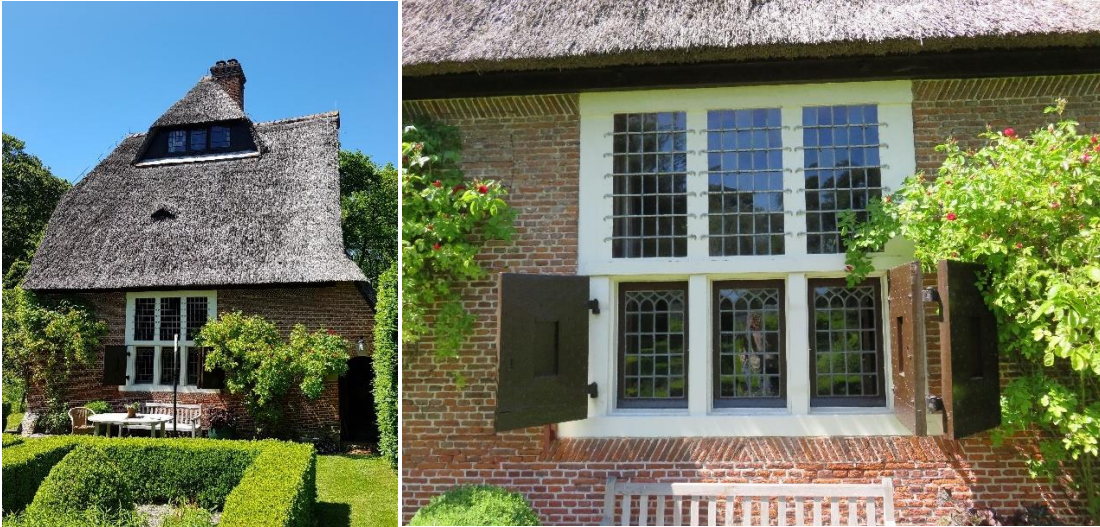
66 en 67 – Achtergevel | Detail gekoppelde vensters met bovenlichten en luiken
