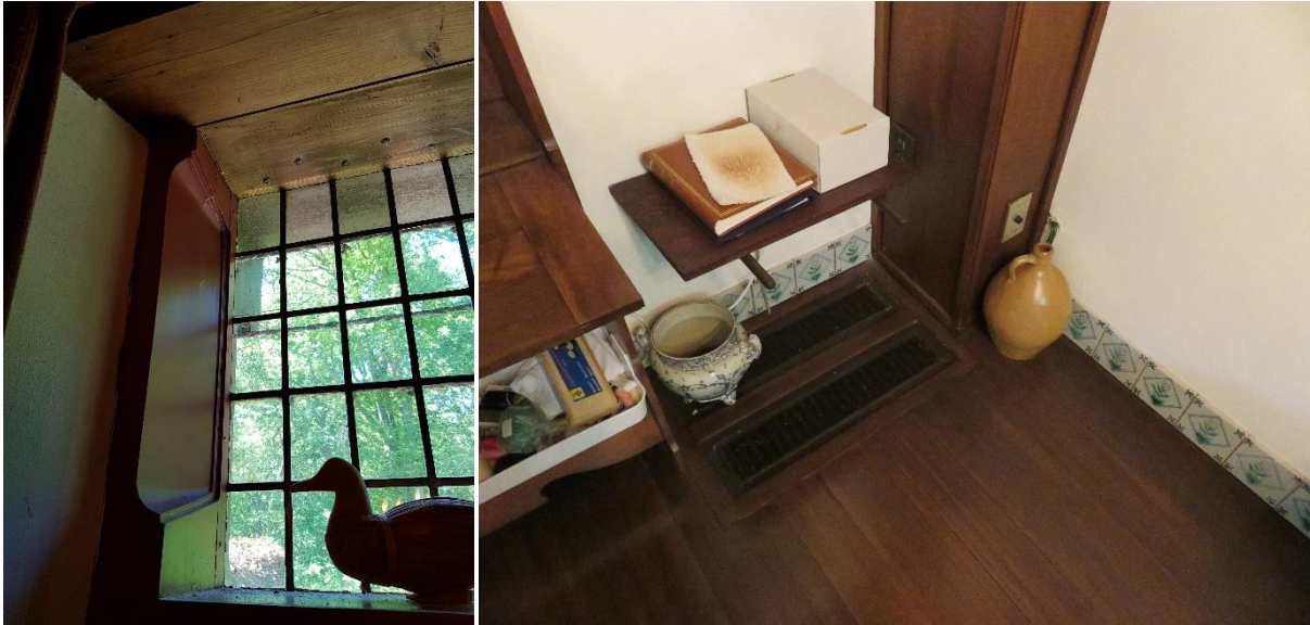
95 en 96 – Detail kloostervenster in opkamer | Vloerconvector markeert locatie oorspronkelijke trapopgang vanuit de zaal
