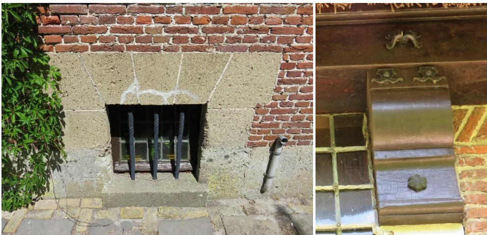
64 en 65 – Detail kelderopening rechterzijgevel | Detail console rechterzijgevel
