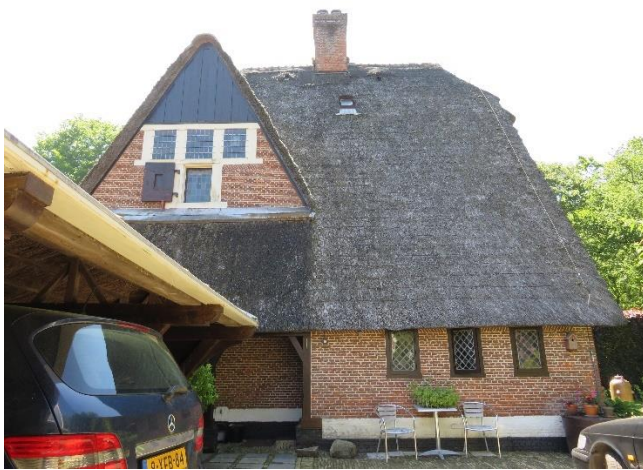
58 en 59 – Linkerzijgevel | Detail dichtgemetseld raam linker zijgevel
