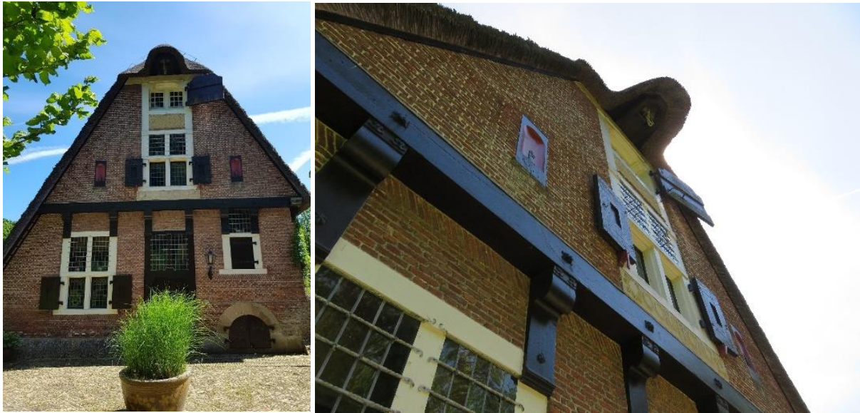
54 en 55 – Voorgevel | Detail topgevel voorgevel
