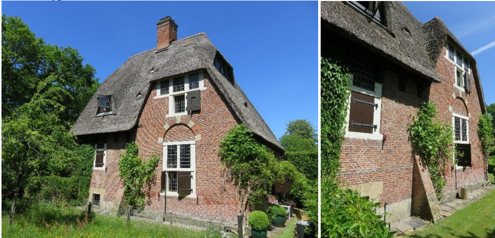
62 en 63 – Rechterzijgevel | Detail steunbeer rechterzijgevel
