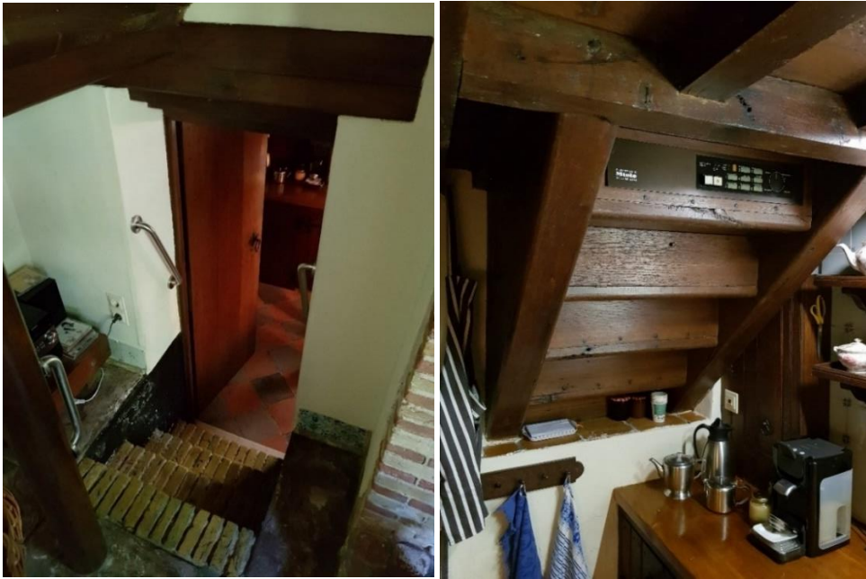
72 en 73 – Ingang kelder met gemetselde traptreden | Onderzijde oorspronkelijke houten trap naar opkamer
