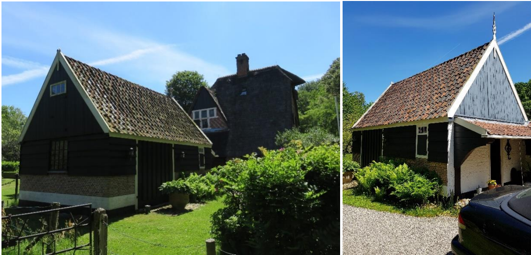
41 en 42 – Noordoostzijde garage | Noordwestzijde garage
