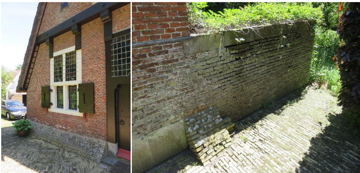
56 en 57 – Steunbeer linkerzijde voorgevel | Muurtje aan rechterzijde voorgevel
