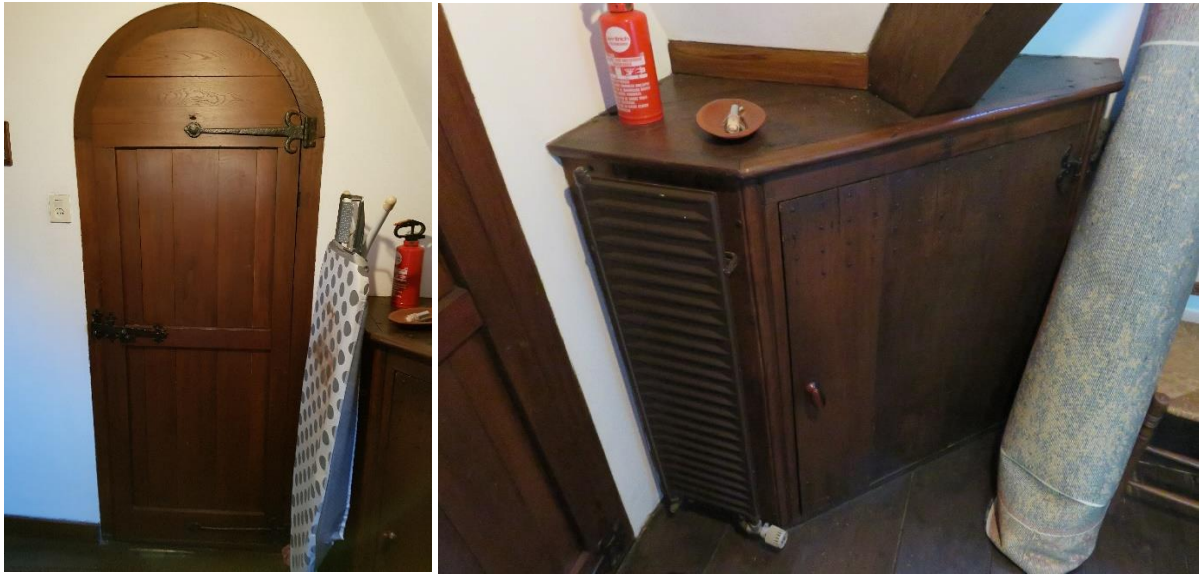
103 en 104 – Tussenwand van houten schotwerk naar kamer | Inlegkast in de gang
