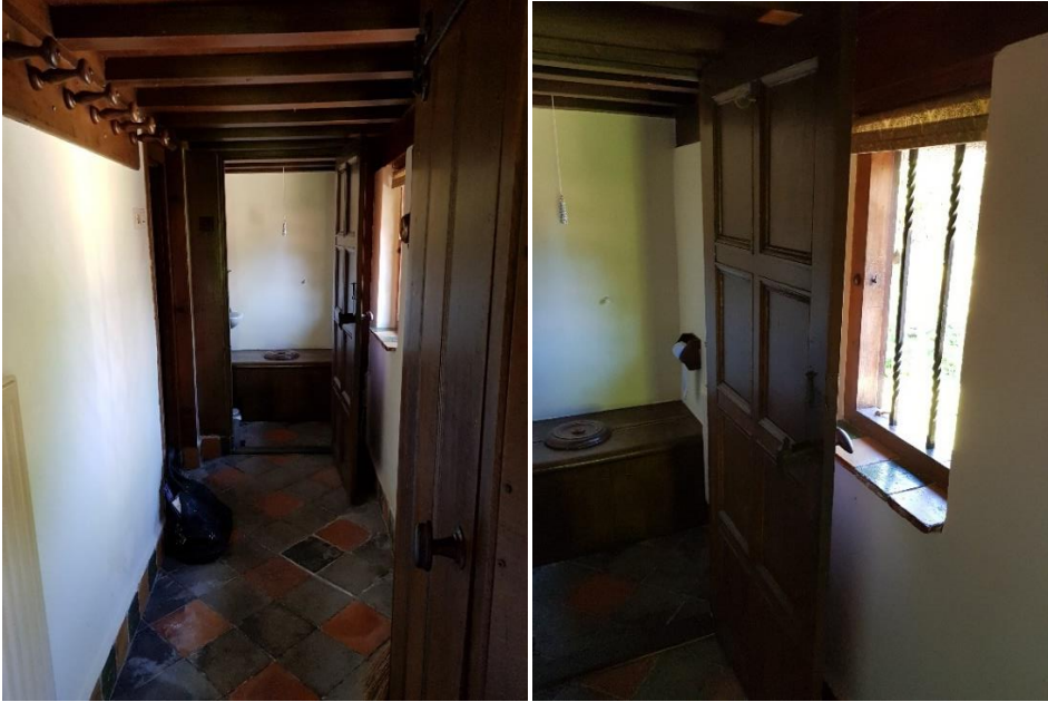
76 en 77 – Entreehal met estriken | Venster met diefijzers en paneeldeur WC
