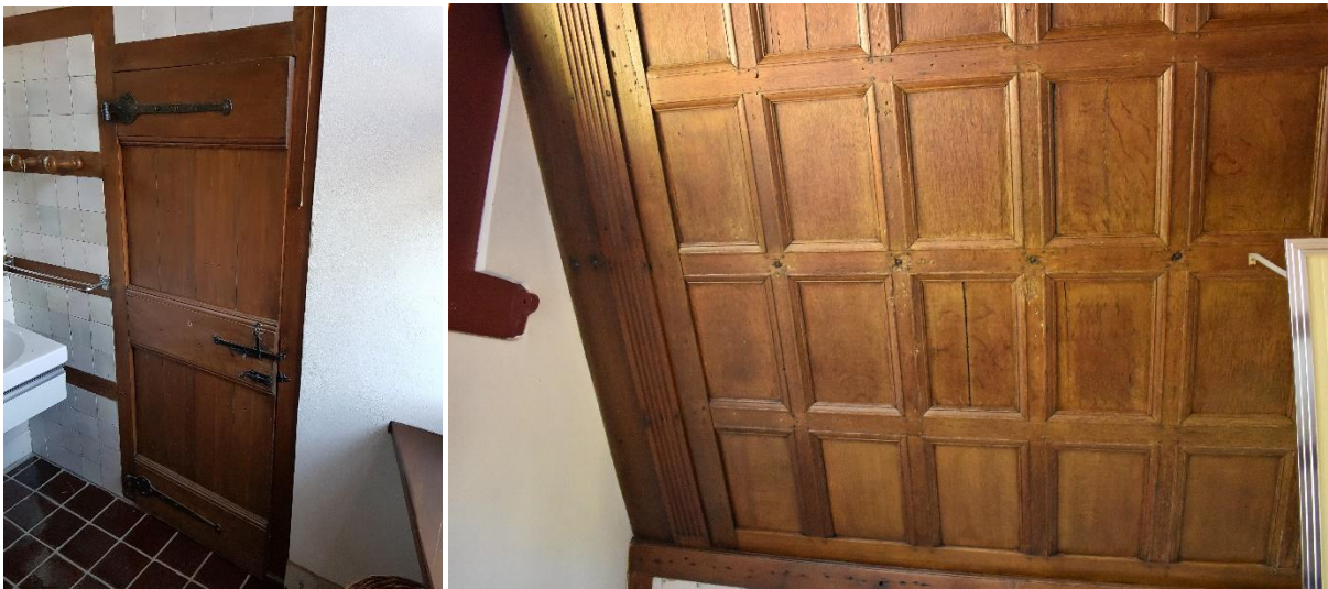
109 en 110 – Opgeklampte deur naar gang | Eikenhouten cassetten afwerking tegen de schuine dakbeschoot
