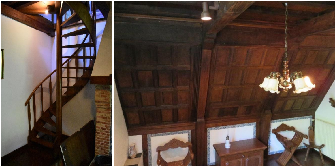
97 en 98 – Wenteltap naar zolder met luik naar keuken | Knieschotten en eikenhouten cassetten afwerking tegen dakbeschot
