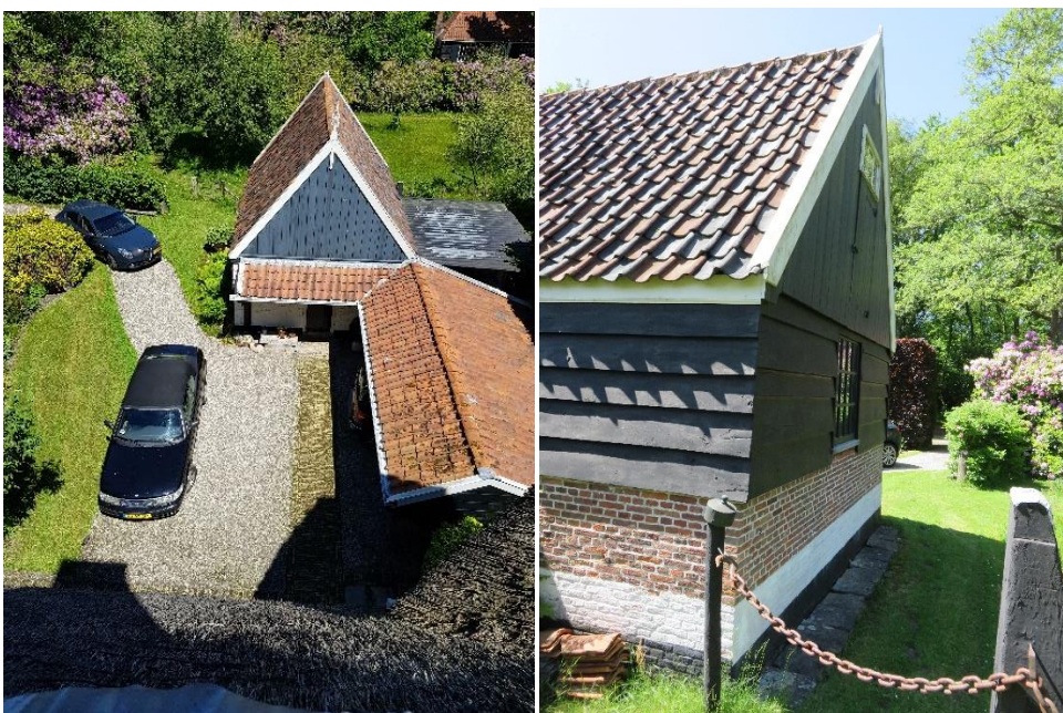
43 en 44 – Zicht vanuit zolderraam op garage en halfopen overkapping | oostgevel garage
