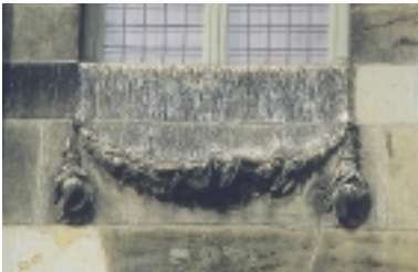
Ernstig door duivenpoep vervuild geveloppervlak met festoen. (foto MvR)
