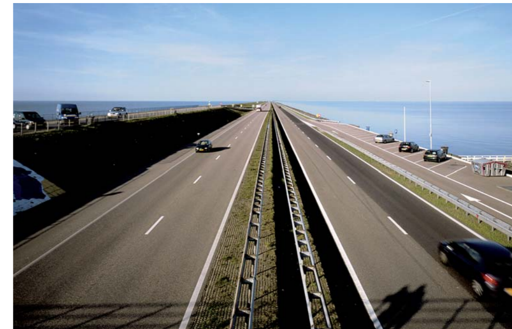
In 1976 is de voor rails gereserveerde ruimte benut voor het verbreden van de rijweg
