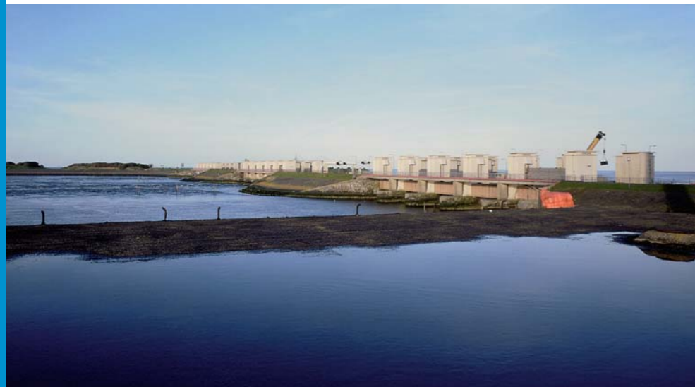
De Stevinsluizen bij Den Oever
