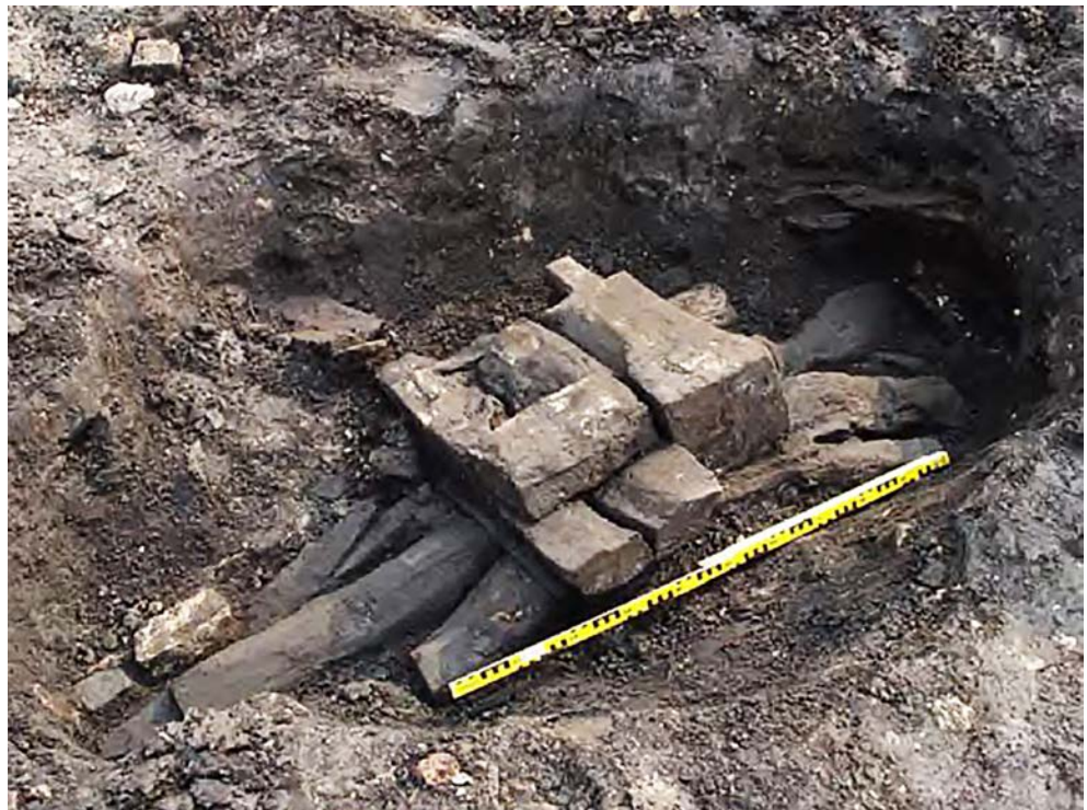
Afb. 7.3 Poer van grote stukken hergebruikt hout uit opgraving Rotterdam-Laurensenhof. (Bron: Ploegaert 2009, 56, afb. 20.1)
