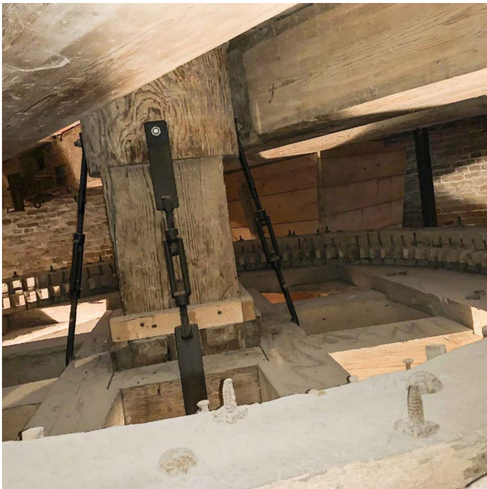
Afb. 9.1 In De Groot/De molen van Piet (Alkmaar, 1769) is een scheepsmast hergebruikt als koningsspil. Op de plaats waar andere constructie-elementen door middel van houtverbindingen zijn vastgezet heeft de van oorsprong ronde mast vlakke zijden gekregen. (Bron: www.molens.nl / Wim Giebels)
