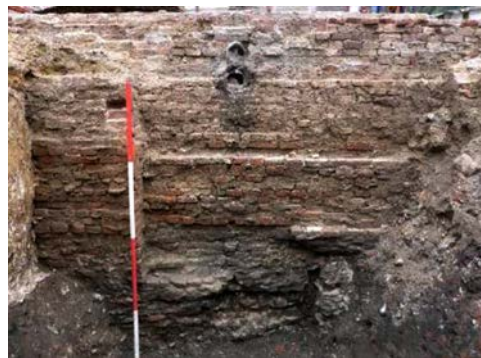
Afb. 7.5 Onderzijde van de kademuur van de Binnendieze in 's-Hertogenbosch. Links van de jalon is een grote poer van hergebruikte bakstenen te zien die waarschijnlijk dienstdeed als steunbeer om verzakking van de muur tegen te gaan. (Bron: Aarts 2022, 45, 4.19a)
